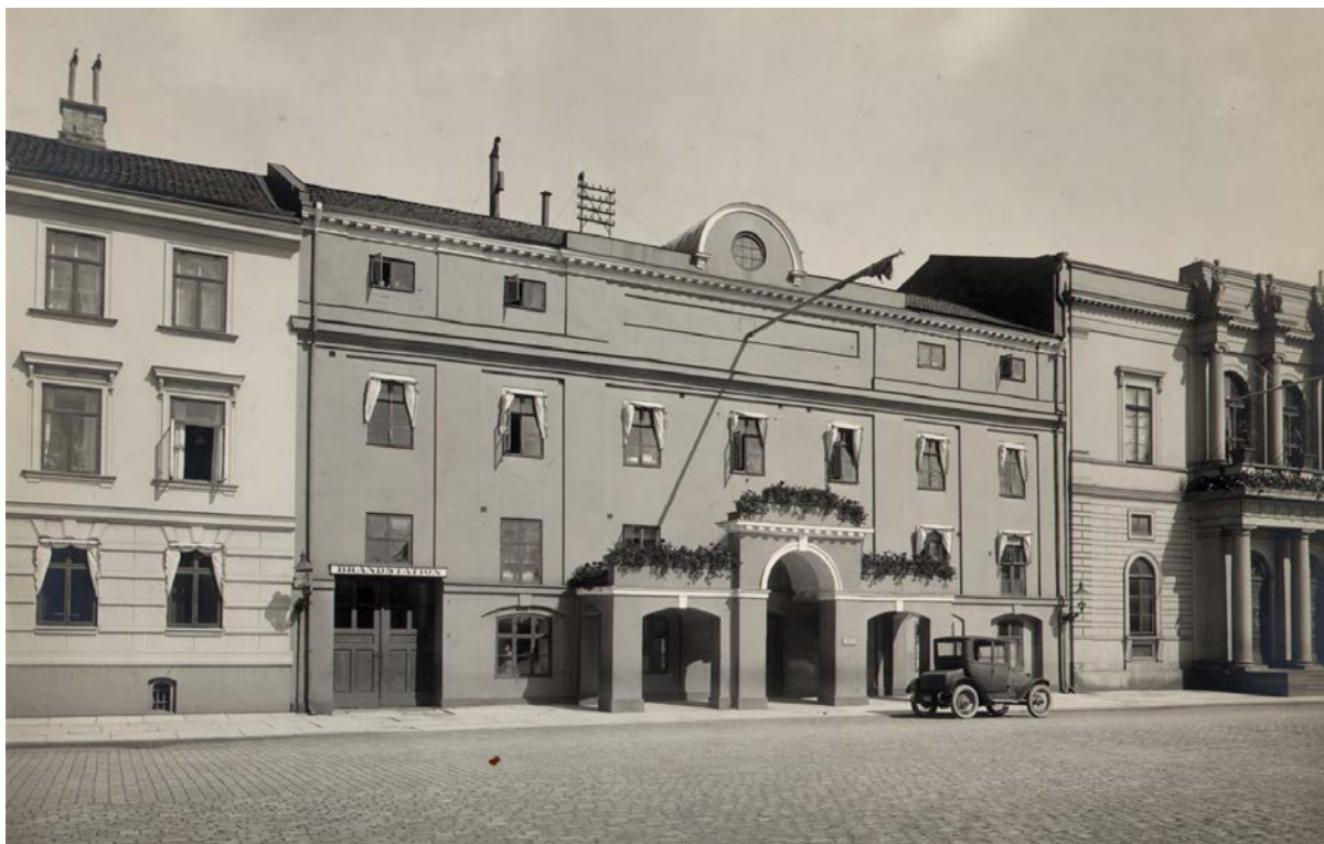
Stadshuset med portar in till brandstationen till vänster i bild. Framför står troligen Dr Gütthlins elbil. Bilden är odaterad men sannolikt tagen kring 1920-talet. Brandporten har höjts så att denna går ovanför simsens. Här syns även hur portiken var smyckad med växter. Källa: GSM
