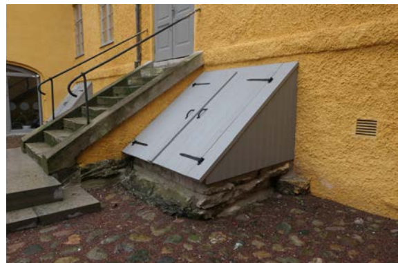
Stadshusgården med den äldre kalkstenstrappan till huvudbyggnaden samt nya överbyggnader till källarnedgångarna.
