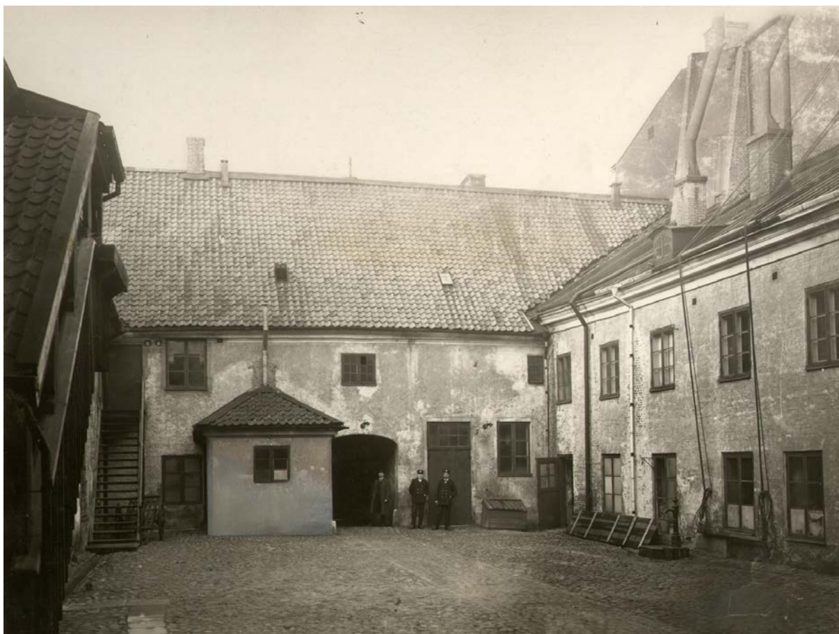
Stadshusets gård 1922 sett mot Postgatan. Mot gårdsfasaden stod ett litet avträde. Dörren samt fönstret till höger om portgången kom på 1930-talet att ersättas mot en garageport. Källa: GSM
