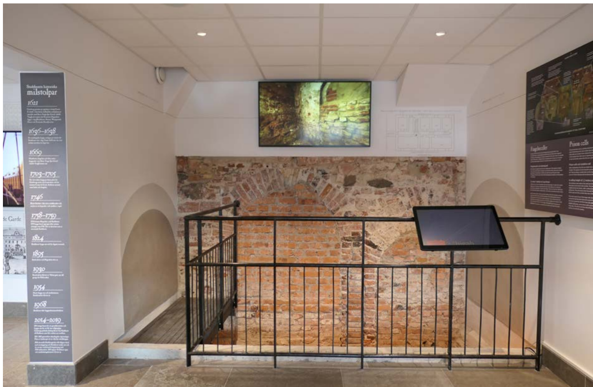
I huvudbyggnadens rum mot torget uppdagades äldre igenmurade valv liksom äldre tegelgolv. Dessa ingår idag i en utställning om Stadshusets historia.
