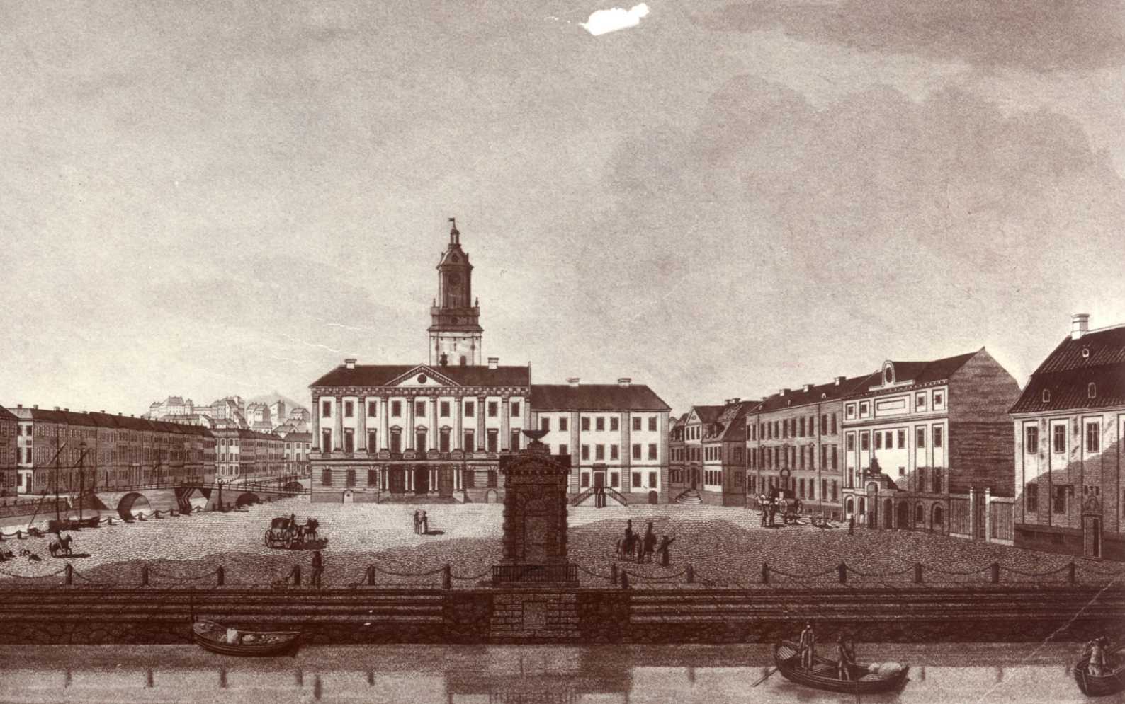
Litografi över Stora torget, odaterad. Bilden är efter det att Stadshuset byggdes på med en våning 1824 men innan Börshuset byggdes på 1840-talet. Källa: GSM
