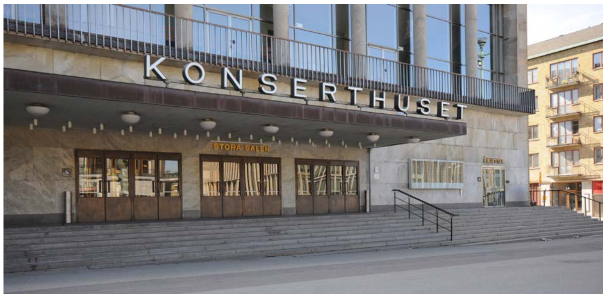
Granittrappan liksom entréernas mässingsportar är ursprungliga och viktiga delar av byggnadens karaktär.
