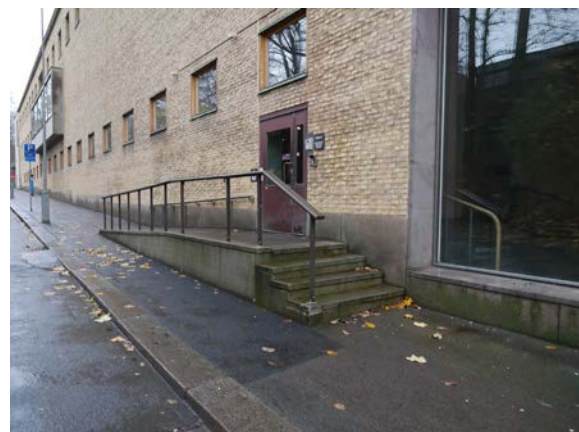
Senare tillkommen ramp och tillgänglighetsanpassad entré.
