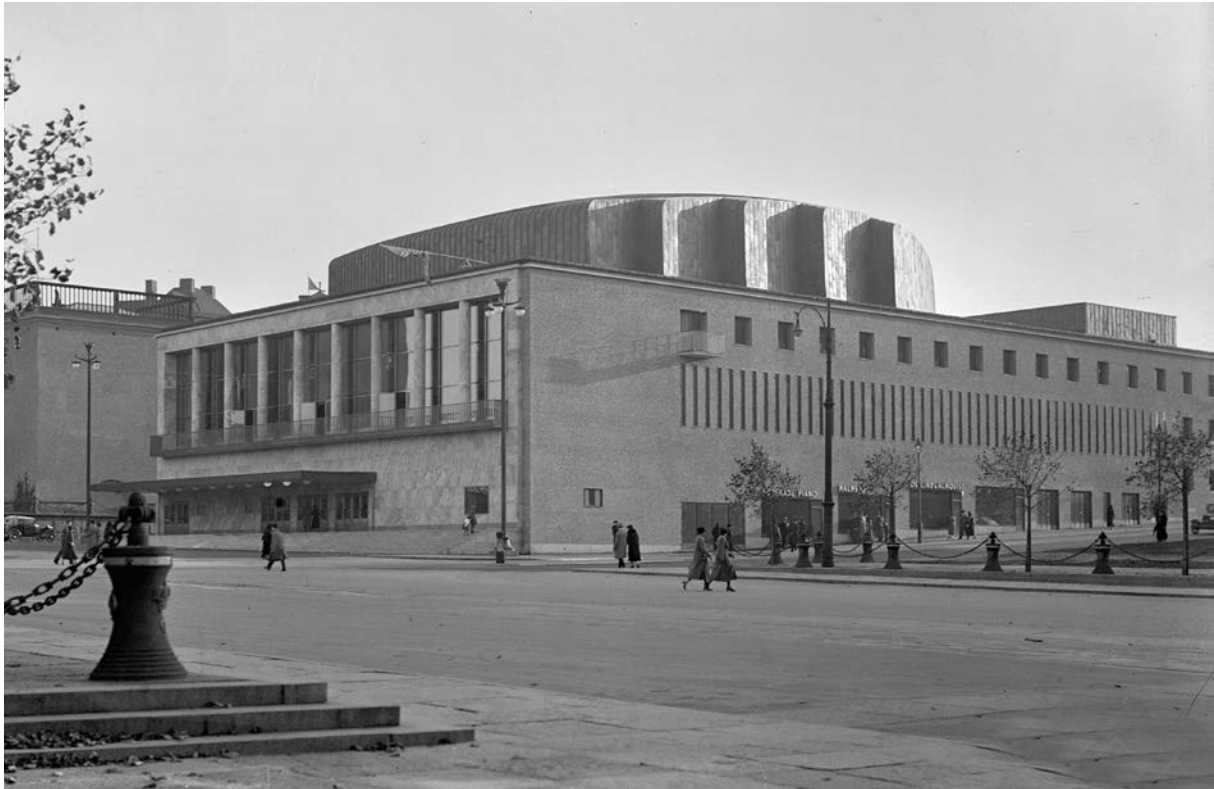
Konserthuset 1935, fasad mot Götaplatsen och Viktor Rydbergsgatan. Notera de stora skyltfönstren i fasad mot Viktor Rydbergsgatan. Källa: KREP
