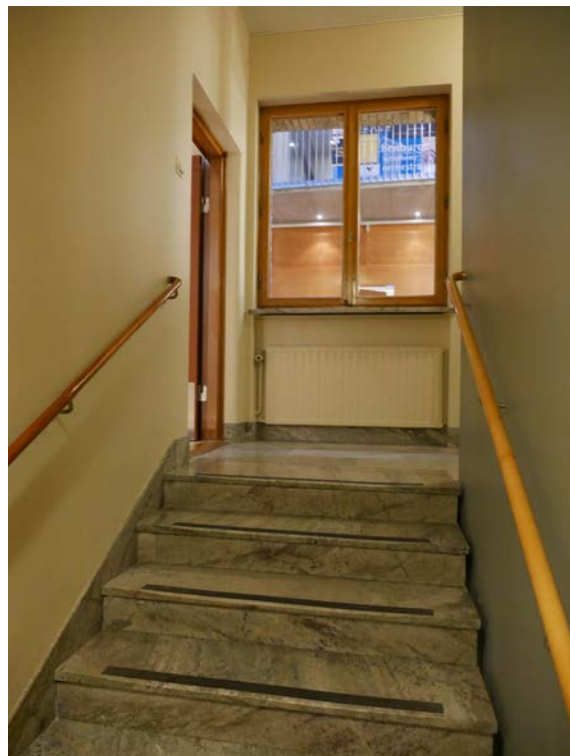
Trapphus A med äldre marmortrappa. I fonden syns ett ursprungligt fönster ut mot den nya ljusgången. De ursprungliga handledarna är bevarade, men kompletterade med senare handledare på trappspindeln.
