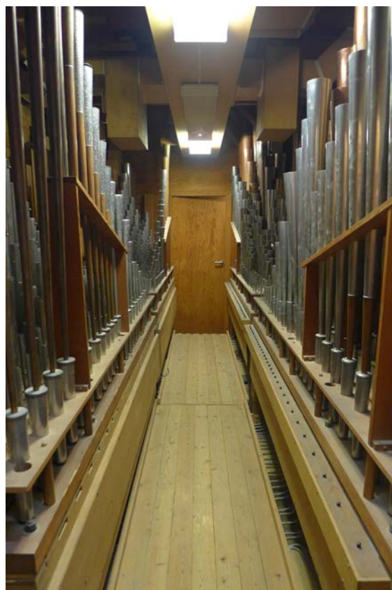
Orgelrummet har bevarat sitt ursprungliga brädgolv och sina väggar och tak av slätspont/furupanel. Det finns även ett antal ursprungliga dörrblad. Orgelverket är från 1937.
