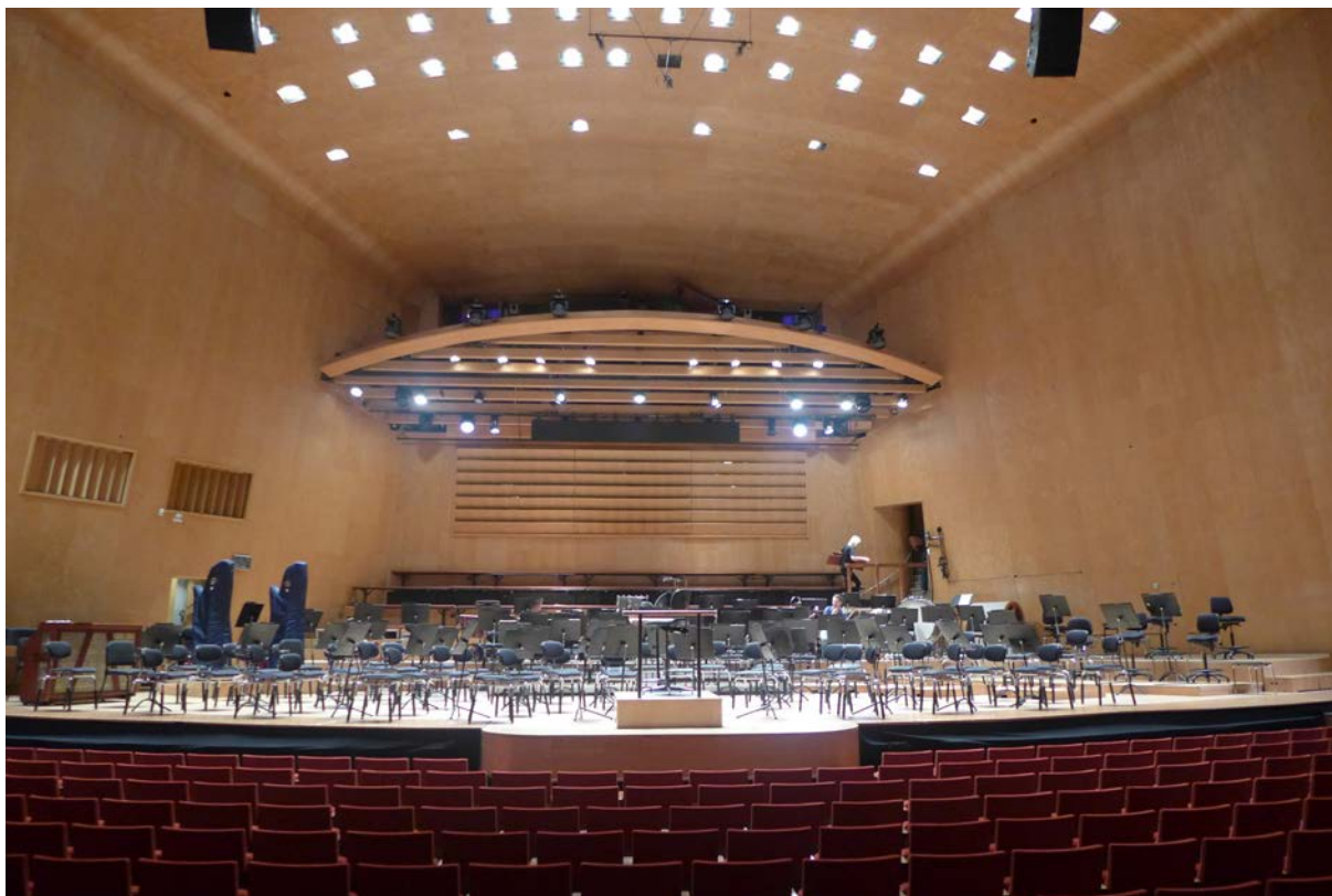
Stora konsertsalen 2017. De vridbara luckorna i scenens fondvägg och ljusrampen/baldakinen är från 2001 och har inneburit en stor förändring av den ursprungliga konsertsalens arkitektoniska utformning. I samband med de arbeten som utfördes 2001 försvann även den dekorativa orgelfasaden. Scenen är idag större än vad den ursprungligen var.
