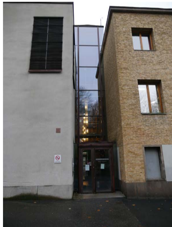
Den äldre byggnaden och tillbyggnaden binds samman av ett inglasat ljusschakt.
