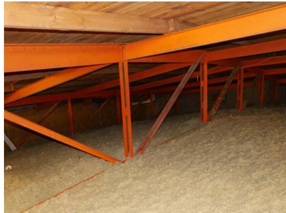
Vindsutrymme ovan Stora konsertsalen med ursprunglig takstolskonstruktion av stål.
