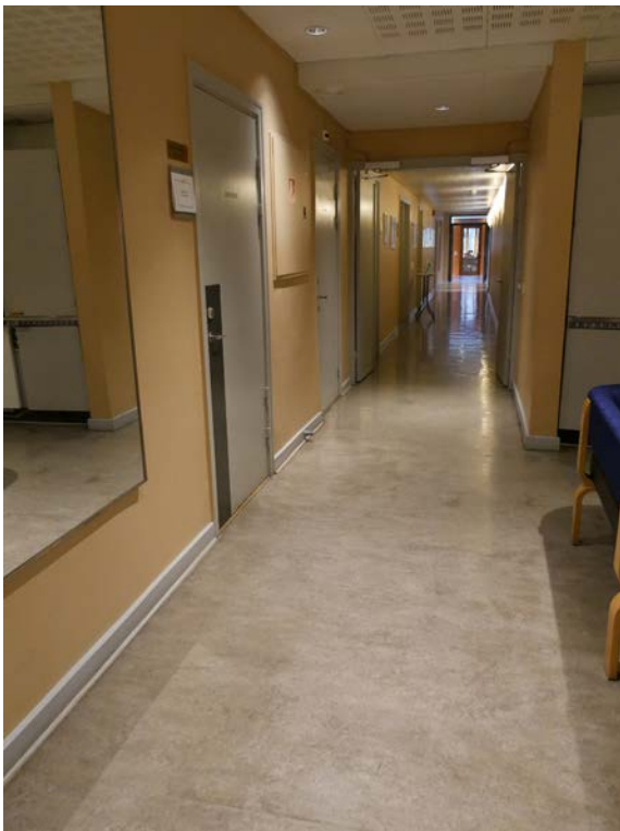
Korridor 365 med bevarade snickerier i form av socklar samt enkla målade dörrblad. I övrigt är ytskikten moderna.
