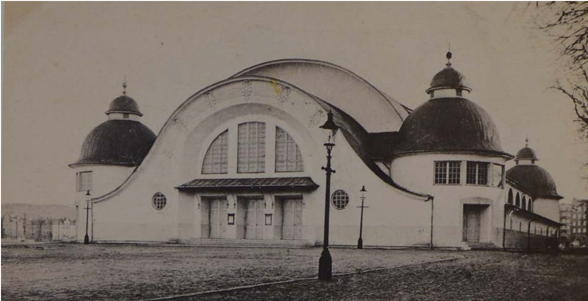
Göteborgs provisoriska konserthus färdigställdes år 1905 på Heden efter förslag av arkitekt Ernst Krüger. Byggherre var det nybildade Aktiebolaget Göteborgs Konserthus. År 1928 brann det provisoriska konserthuset ned och arbetet med att uppföra ett permanent konserthus inleddes. Källa: GSM
