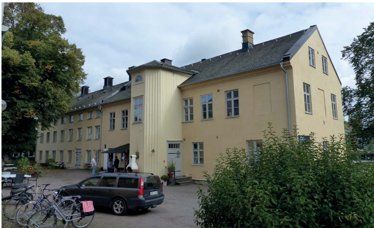
Gårdsbyggnadens norra fasad vetter mot gården.
