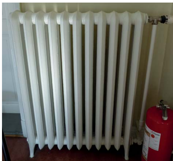
Uppifrån och ned: Hallen med spegeldörrar och kalkstensgolv, det patinerade kalkstensgolvet samt en äldre gjutjärnsradiator.
