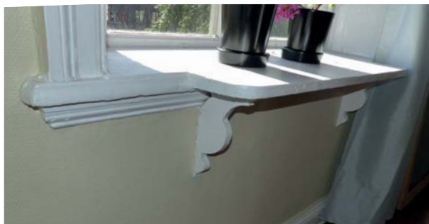
I rum 202 finns dekorativt utformade fönsterbänkar i trä.
