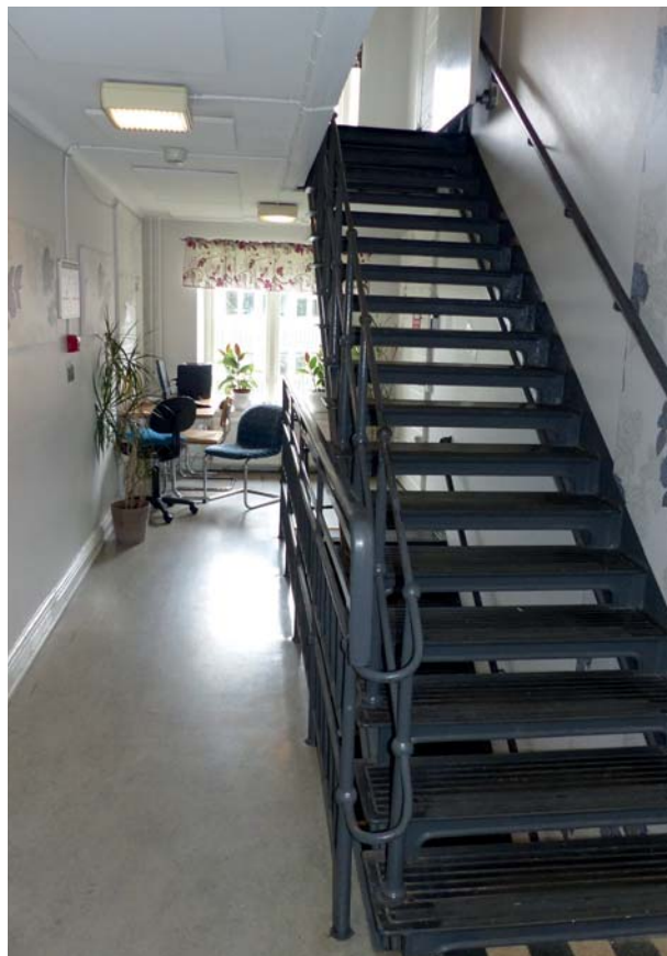
Den äldre gjutjärnstrappan i trapphuset i byggnadens nyare del, här i rum 201.
