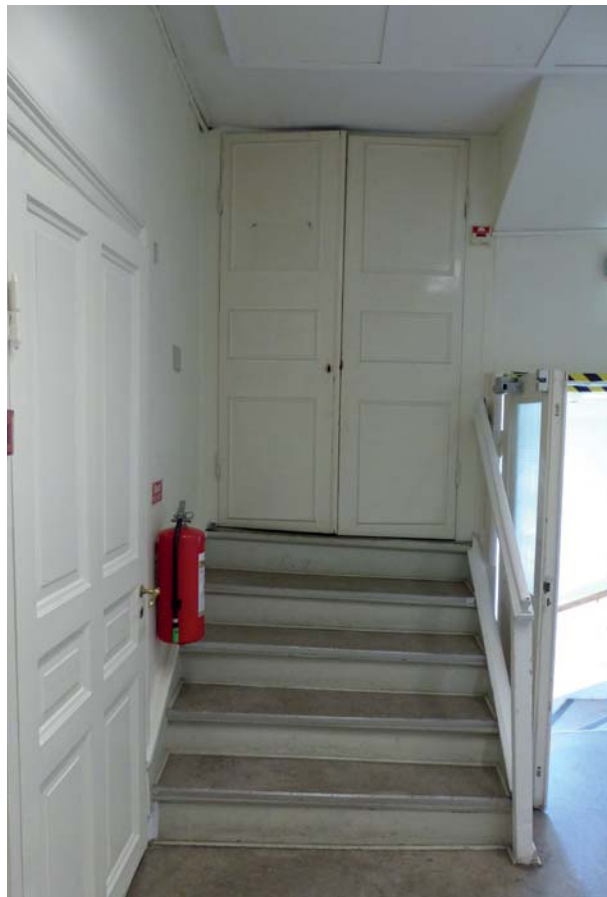
Trappan upp till vinden avgränsas mot hallen på plan två av en äldre pardörr med speglar.
