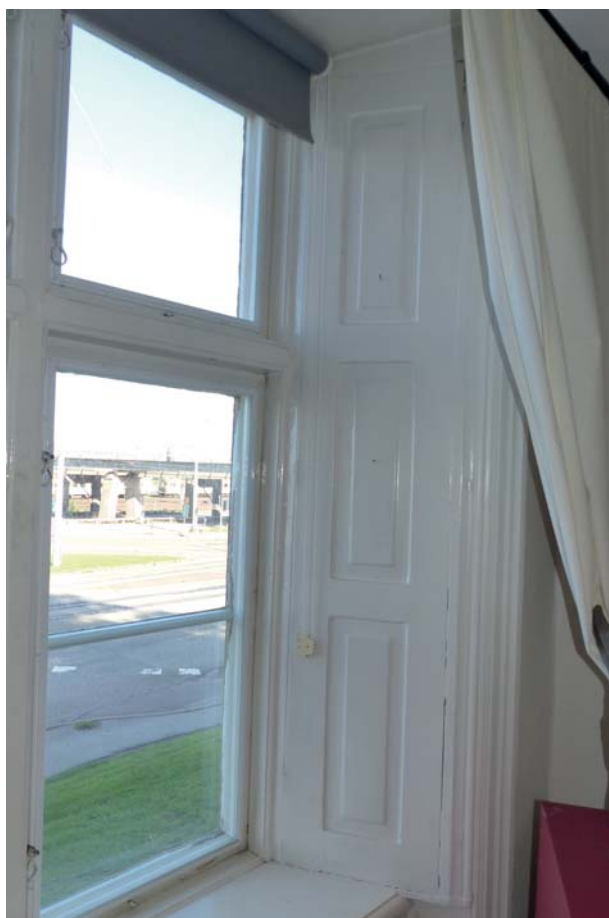
I rum 116 finns infällda fönsterluckor bevarade.
