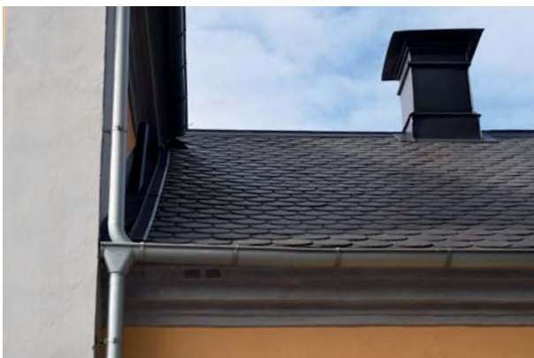
Anslutningen mellan tillbyggnaden och den ursprungliga volymen. Här syns såväl den profilerade takgesimsen som tillbyggnadens nya skiffertak och omklädda skorsten.
