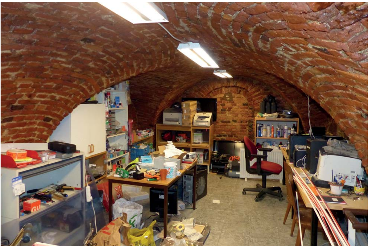
I källaren under byggnadens äldre del finns murade valv från byggnadens tillkomsttid.
