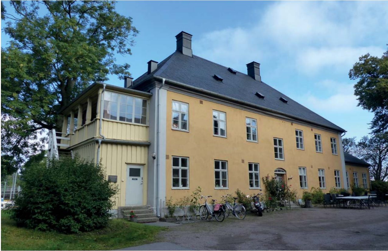
Byggnadens södra fasad vetter mot gårdsplanen.
