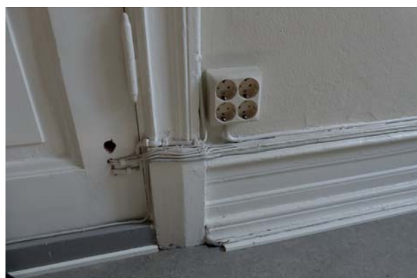
Överst: Bevarad skåpsinredning i det före detta köket i rum 120. Nederst: Exempel på spegeldörrar och profilerade lister, liksom på mindre varsamma eldragningar.
