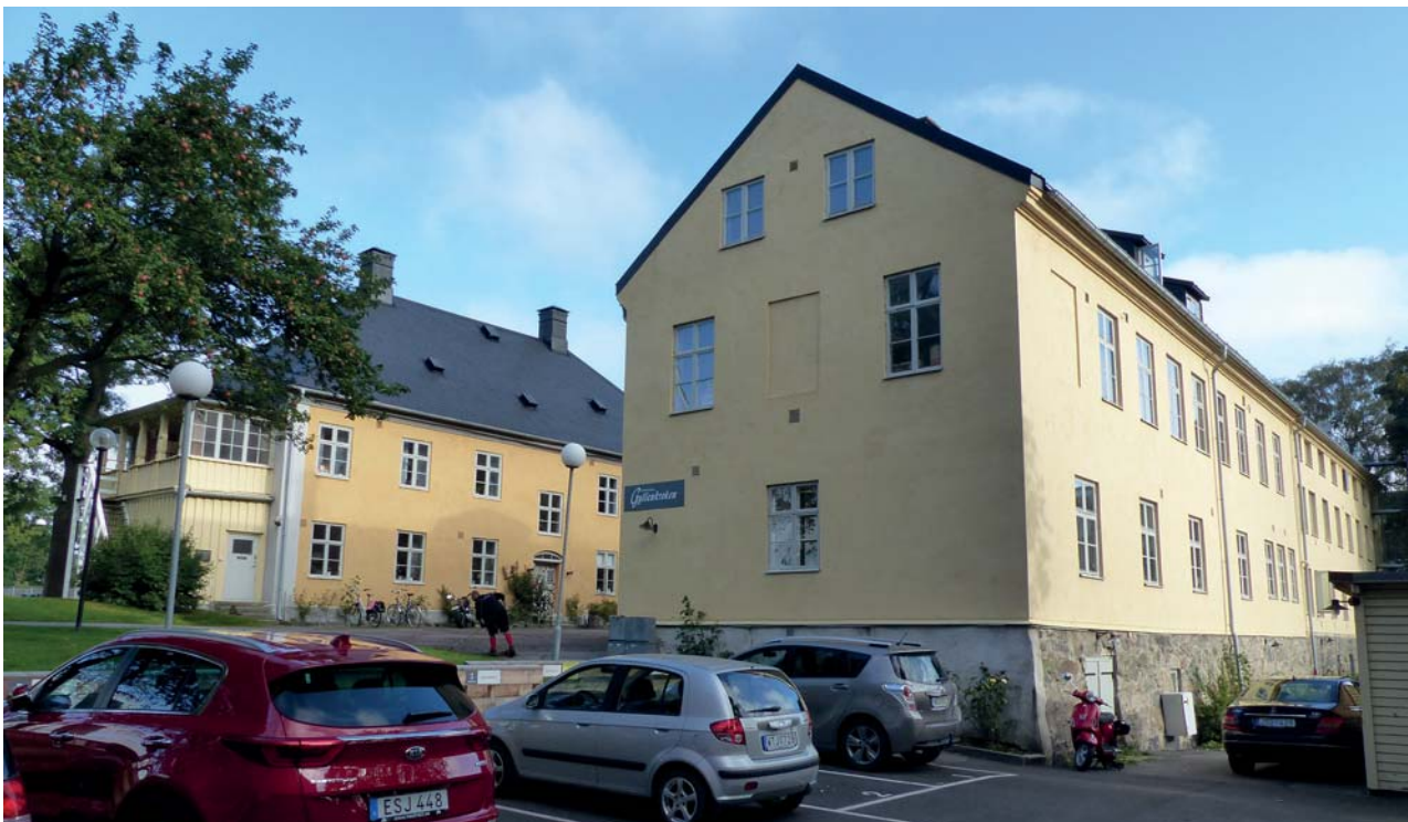
Gårdsbyggnadens västra fasad som, till skillnad från den södra fasaden, har en putsad sockel.
