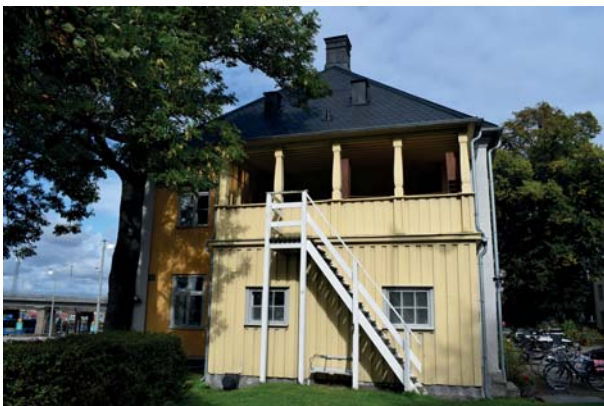
Västra fasaden med tillbyggnaden i trä från 1916.
