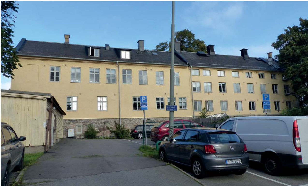
Gårdsbyggnadens södra fasad vetter mot en parkering och, innanför denna, ett mindre trädgårdsparti.
