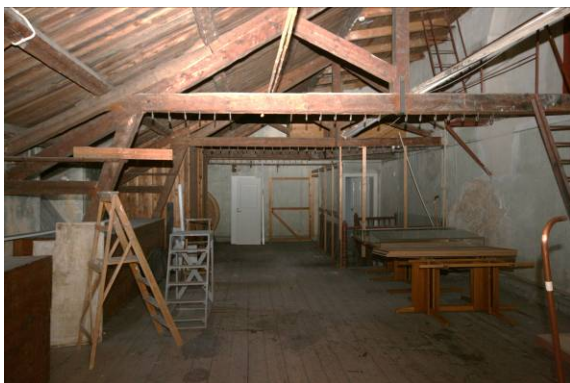
Takstol och undertak är original.
