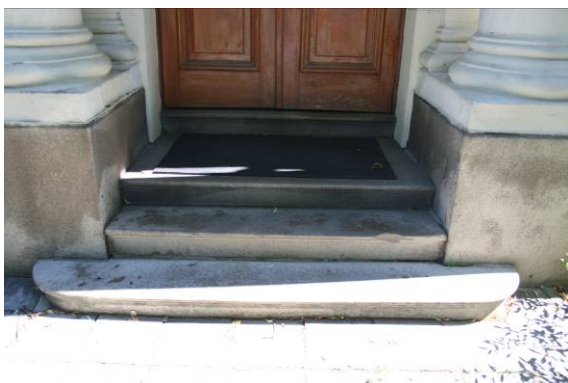
Trappa till huvudentré i granit.
