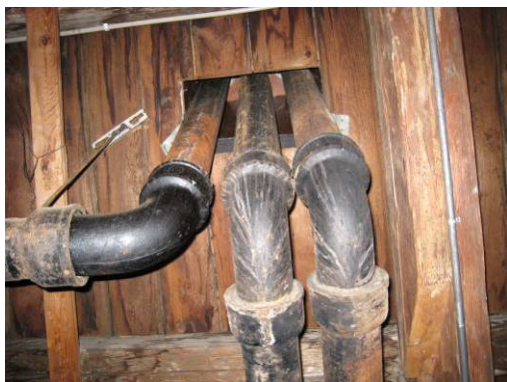
Avloppsluftare av gjutjärn.
