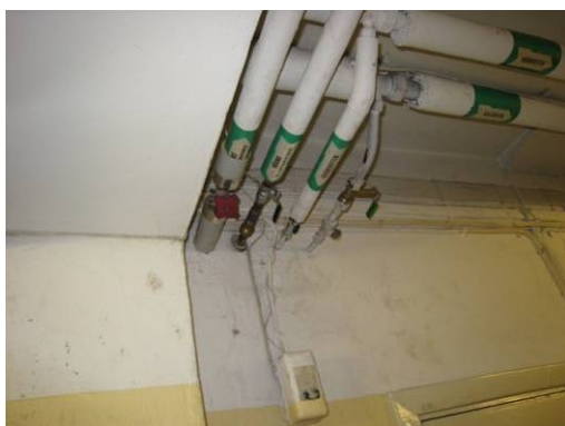
De flesta av ventilerna i källarens rörstråk är utbytta.
