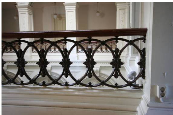
Räcke i gjutjärn.
