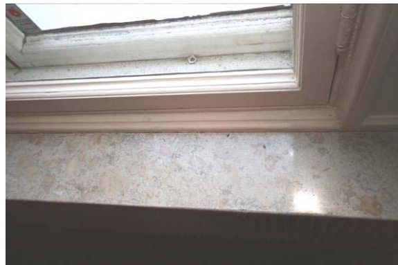
Fönsterbänk är sannolikt senare.
