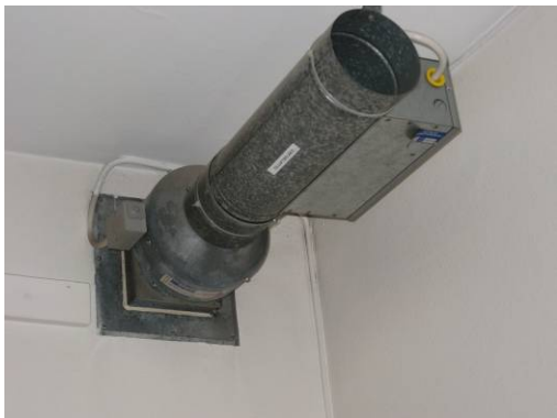
Tilluftsaggregat för förråd 125.
