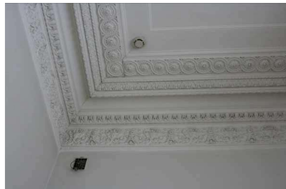
Detalj av stuckatur i rum 313.
