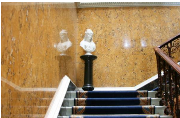
Väggar i stucco marmo.
