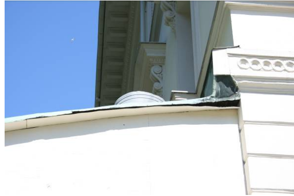
Tak av kopparplåt.
