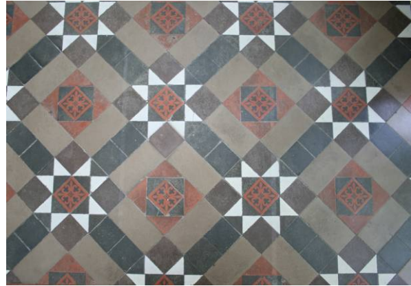
Golv belagt med s.k. engelska tiles.
