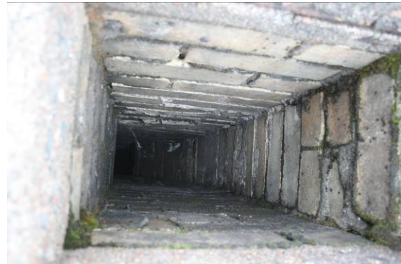
Insida av skorsten.
