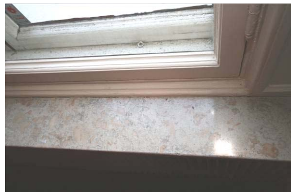
Fönsterbänk är sannolikt senare.
