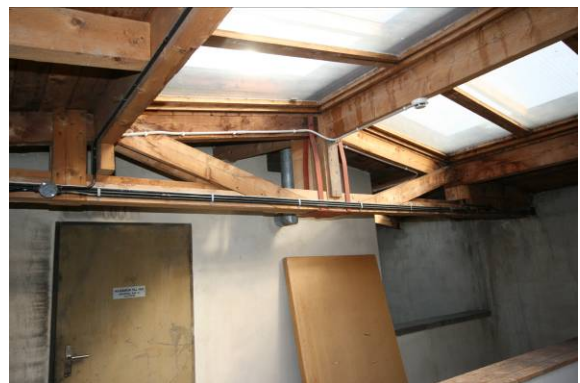
Takstol och fönster från 1950-talet.
