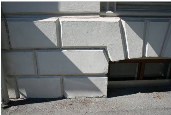
Fasaden går ända ner i mark, utan sockel.
