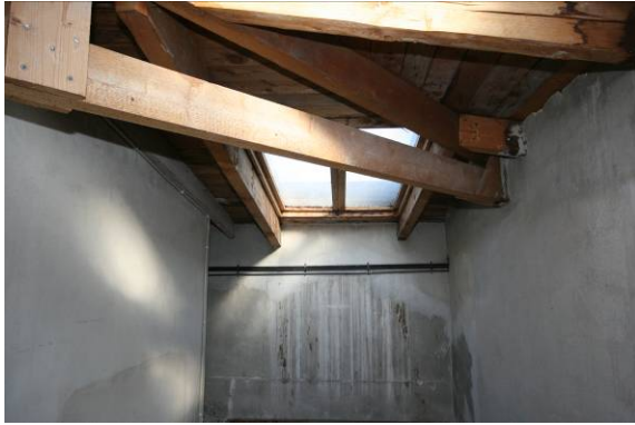
Putsade väggar och synlig takstol.
