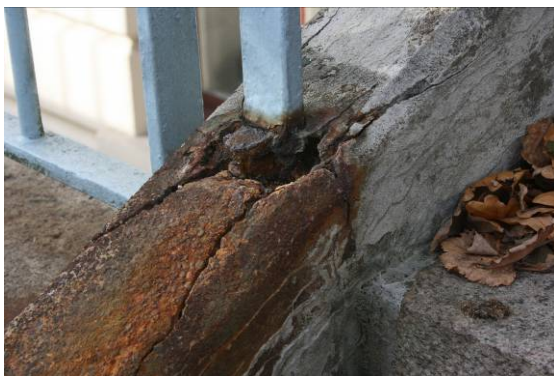
Infästningsskador, smide.
