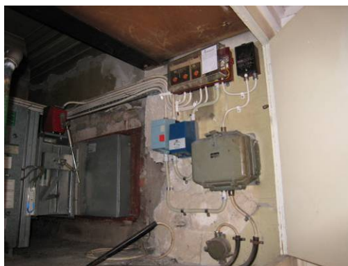
Analog styrutrustning för aggregat TA3.
