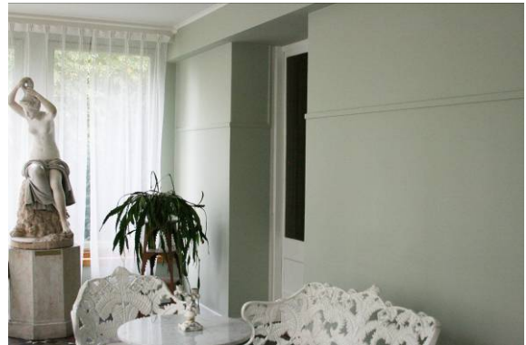
Målad och skivklädd vägg.
