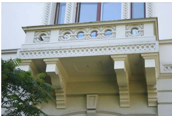
Balkong med gjuten balustrad.
