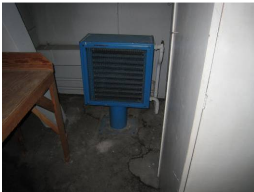
Torkaggregat i torkrum på vindsplan.
