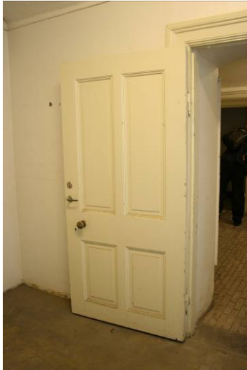
Spegeldörr i källaren, original.
