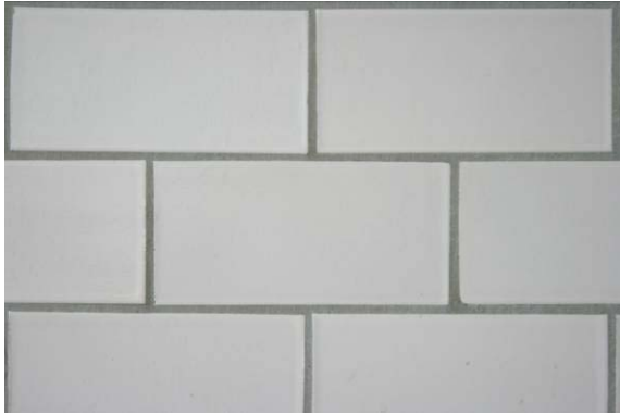
Kaklad vägg i s.k. half tile-format.
