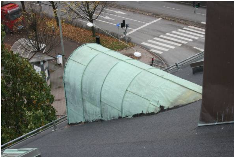
Äldre takkupa klädd med kopparplåt
