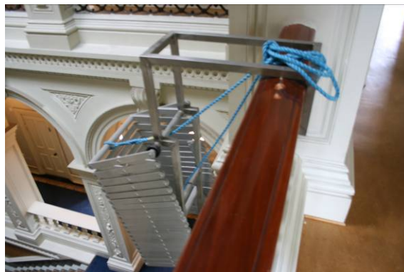
Skada i handledare efter utrymningsstege.
