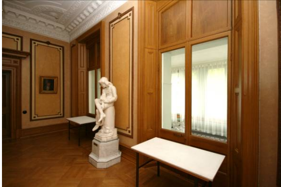
Fönster omgjorda till dörröppningar.
