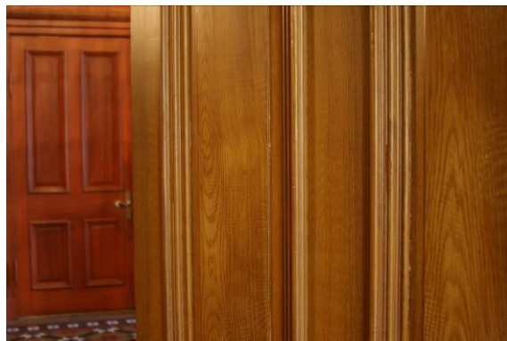
Dörromfattning med ekådring, i bakgrunden syns en dörr med mahognymåleri i hallen.
