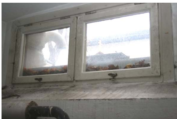
Fönster i marknivå.
