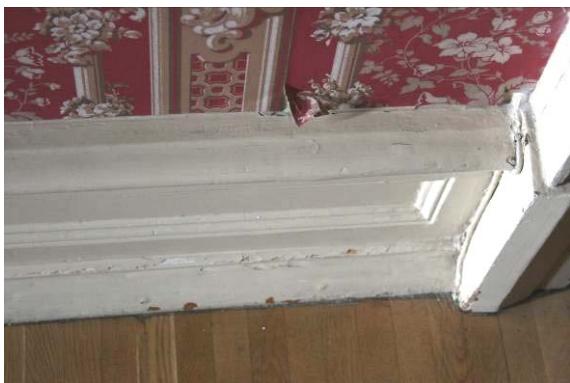
Sockel med relativt omfattande färgsläpp.
