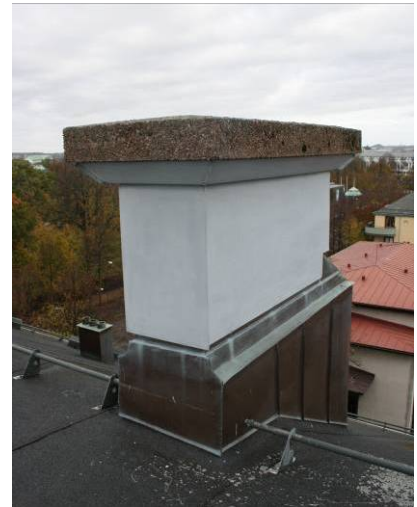
Skorstenarna putsades på 1980-talet.
