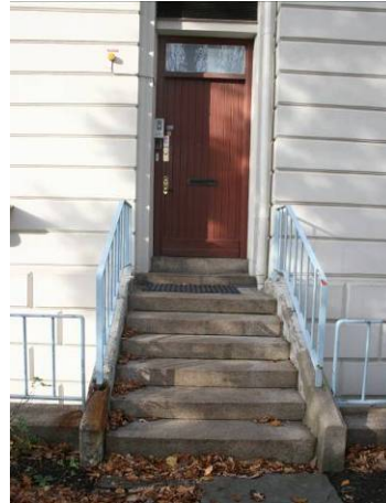
Entrétrappa mot Parkgatan.
