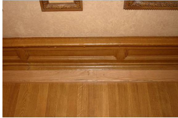
Åtgärd för att undvika nötning mot sockel.
