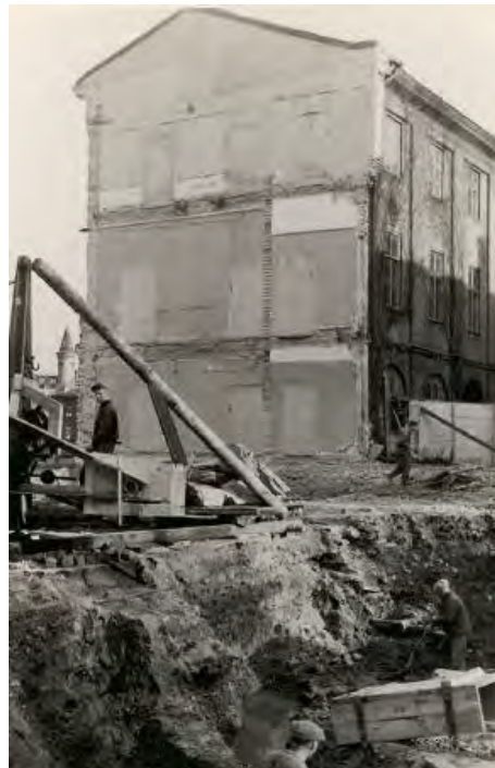
Foto från rivningen av kommandantshuset och rådhuset. (Göteborgs stadsmuseum)
