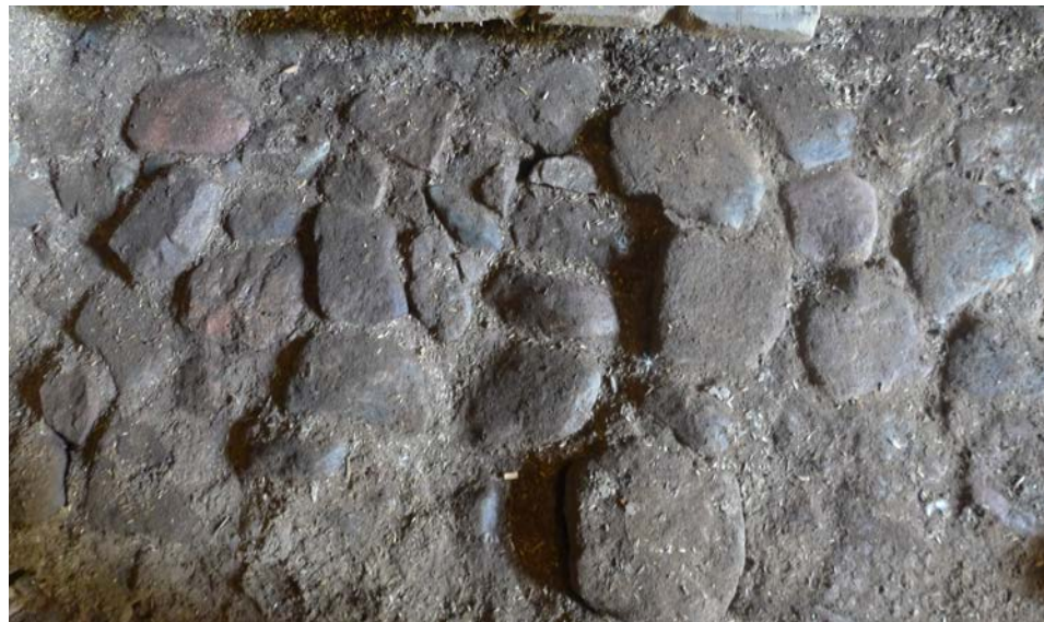
Äldre stenläggning framkom under bef. golvbjälklag i rum 102, 2017-08-16
