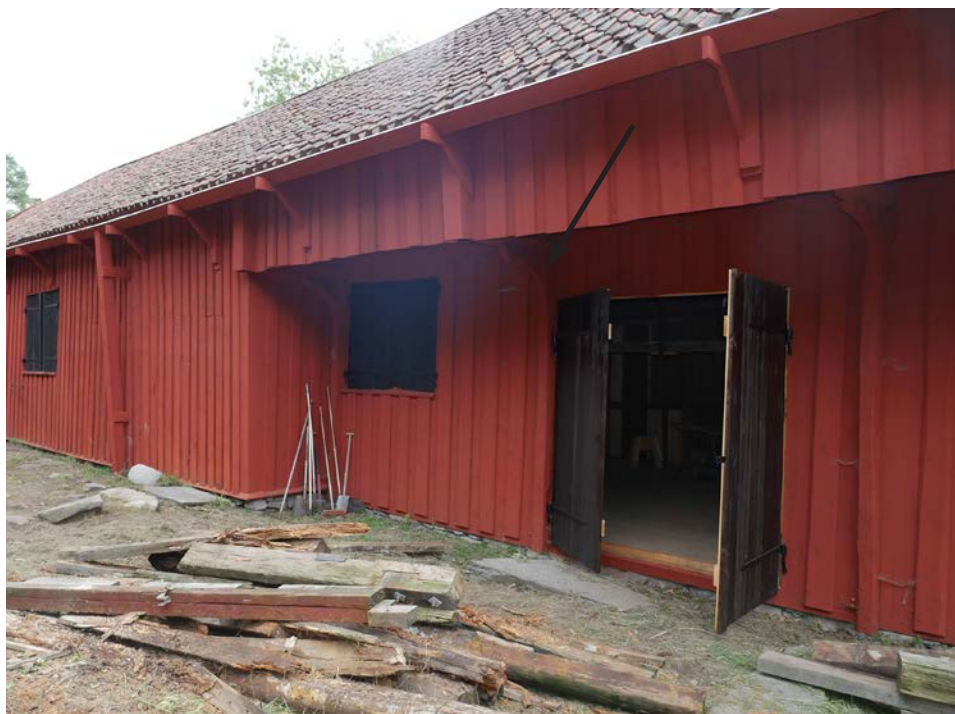
Den f d indragna delen (skullskottet), norr om portlidret är återställt med nya sk rotknän (ex markerade med svart pil). 2018-08-22
