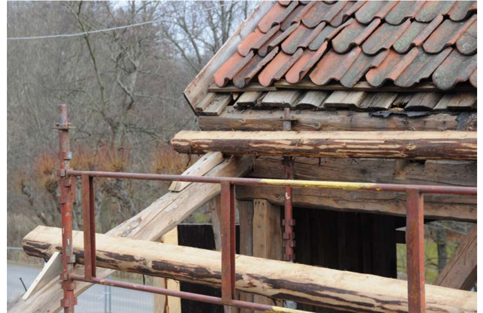
Pågående arbete med nytt åstak på snedtäckan och mötet mot Östra längan. 2017-03-16
