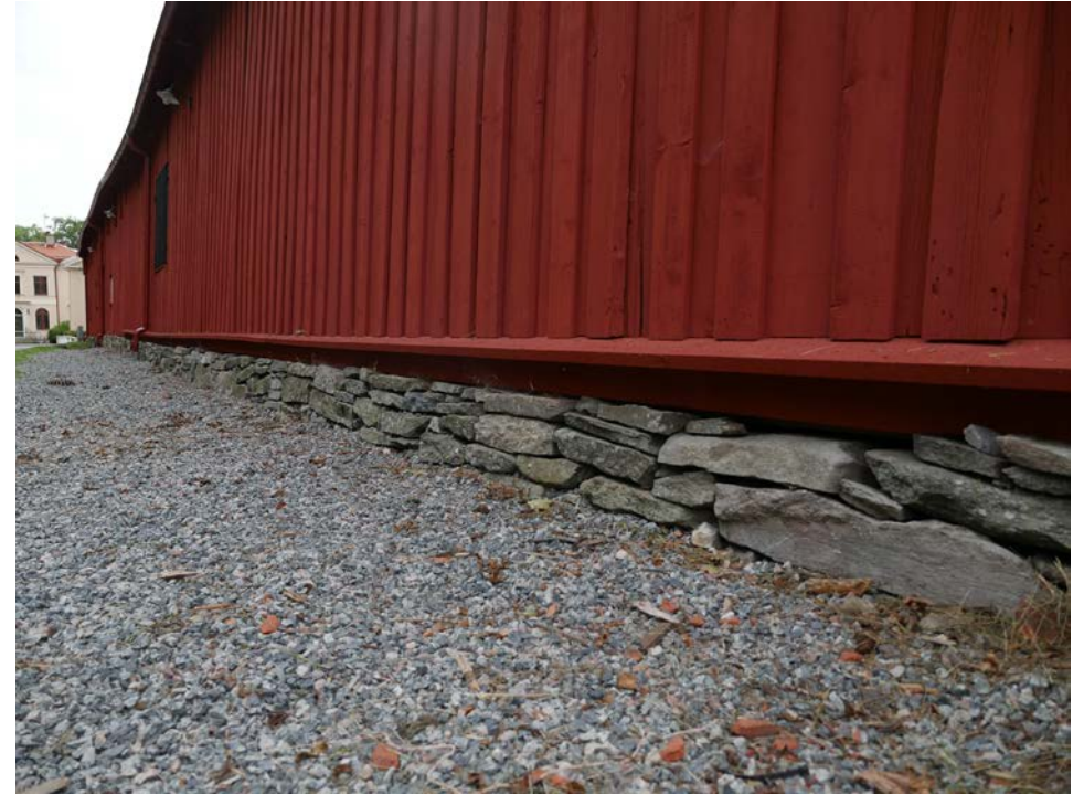
Efter avslutade arbeten med justering av grundmur mot öster, ny dränering och makadam samt komplettering av ny vattbräda. 2018-08-22
