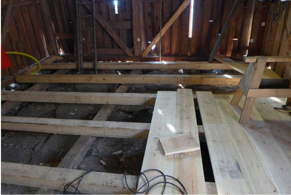
Arbete med nytt bjälklag och med golvläggning med kilsågat golv. 2017-11-29
