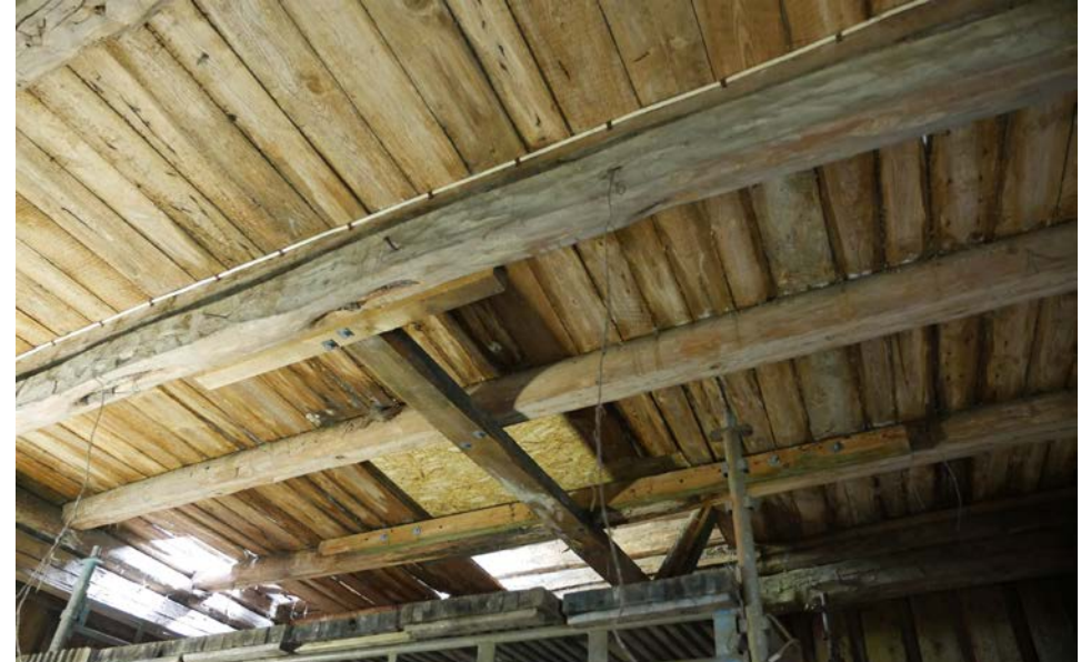
Loftet före restaurering med bl a stomskador och rötskador i golv, där foto t.h. visar genombrutet bjälklag sett från våningen under. 2017-02-16 och 2017-05-22
