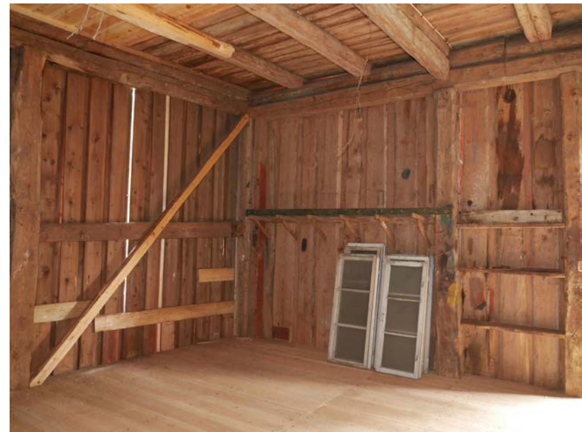
Arbete med nytt bjälklag och med golvläggning med kilsågat golv. 2017-11-29
