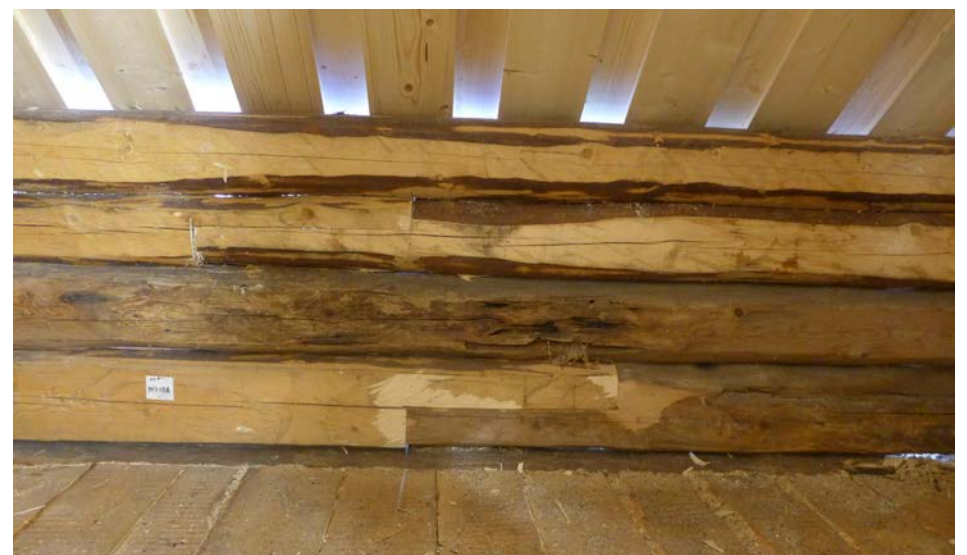
Överst t.v. visar tidigare lagningar och förstärkningar i sydvästra hörnet som medfört sättningar och förskjutningar av stommen. Övriga foton visar under arbete med bl a lagningar och utbyte av övre timmervarven mot syd. Det byttes även en del takinbrädning i sydvästra hörnet. 2017-05-22, 2017-08-16 och 2017-08-31
