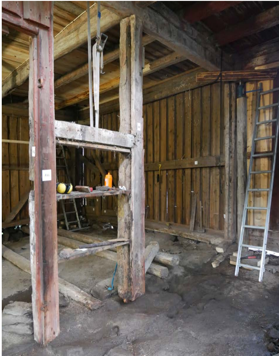
Rum 101 i söder, demontering av delar pga stomlagningar. Vid utrivning av bjälklag framkom en äldre stenläggning med större hällar i marken. 2017-06-16
