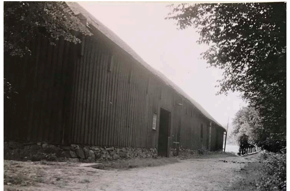
Foton till höger från 1940-talet som visar dels nordöstra fasaden med den sammanbyggda norra längan som idag är riven samt foto från östra fasaden sett mot norr. Källa: Göteborgs stadsmuseum
