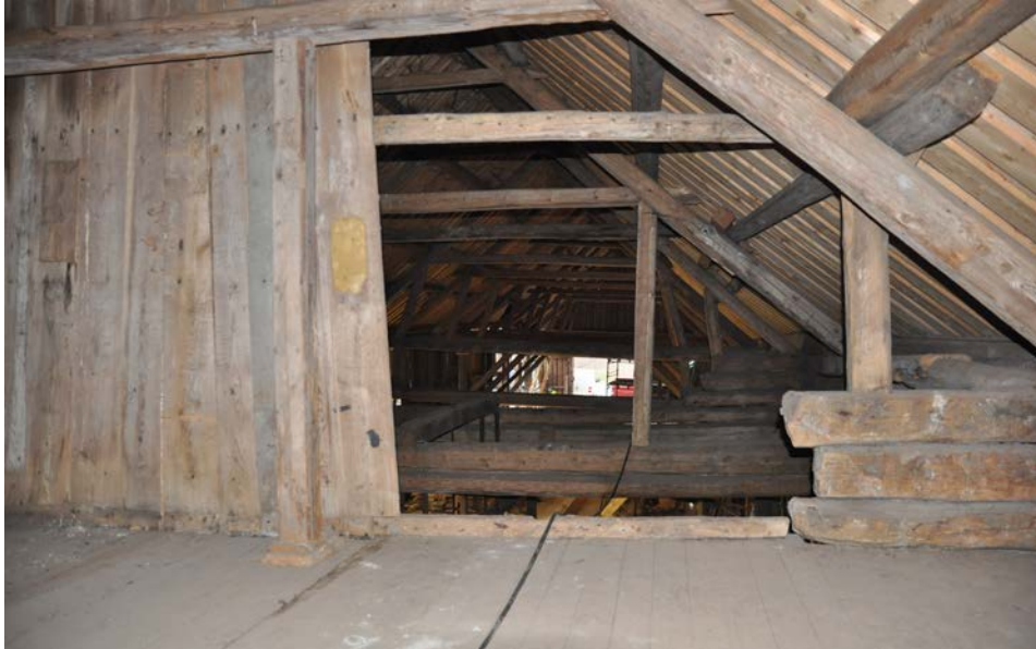
Loftet före restaurering med bl a stomskador och rötskador i golv, där foto t.h. visar genombrutet bjälklag sett från våningen under. 2017-02-16 och 2017-05-22
