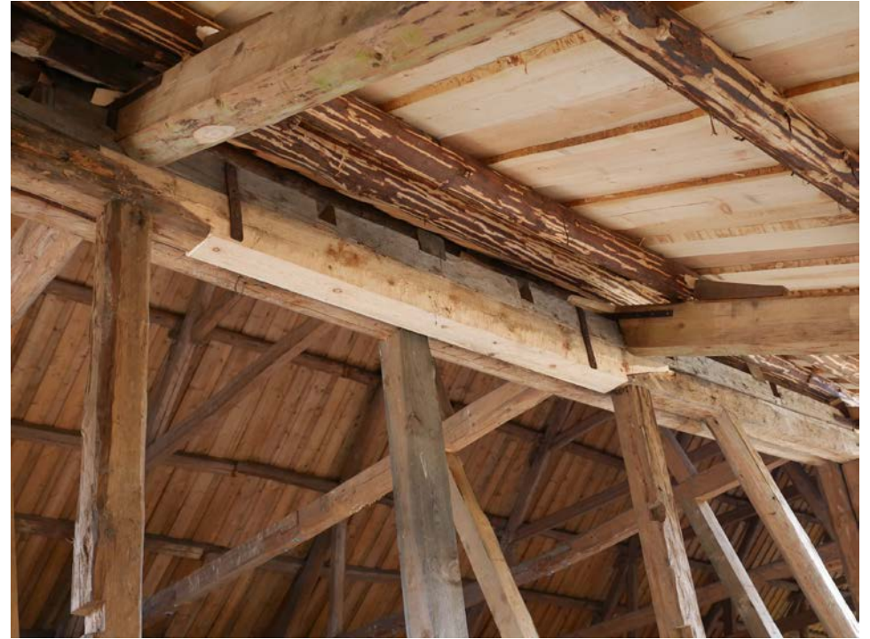
Pågående arbete med nytt tak till snedtäckan. Ny takinbrädning har monterats på åsarna. 2017-03-30
