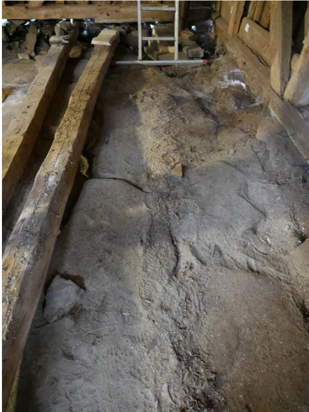
Äldre stenläggning återfunnen under befintligt bjälklag i södra rummet, 2017-06-16
