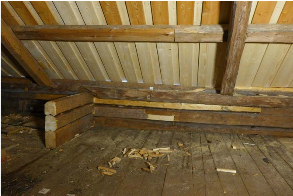
Förstärkningar och lagningar mot öster. 2017-06-28
