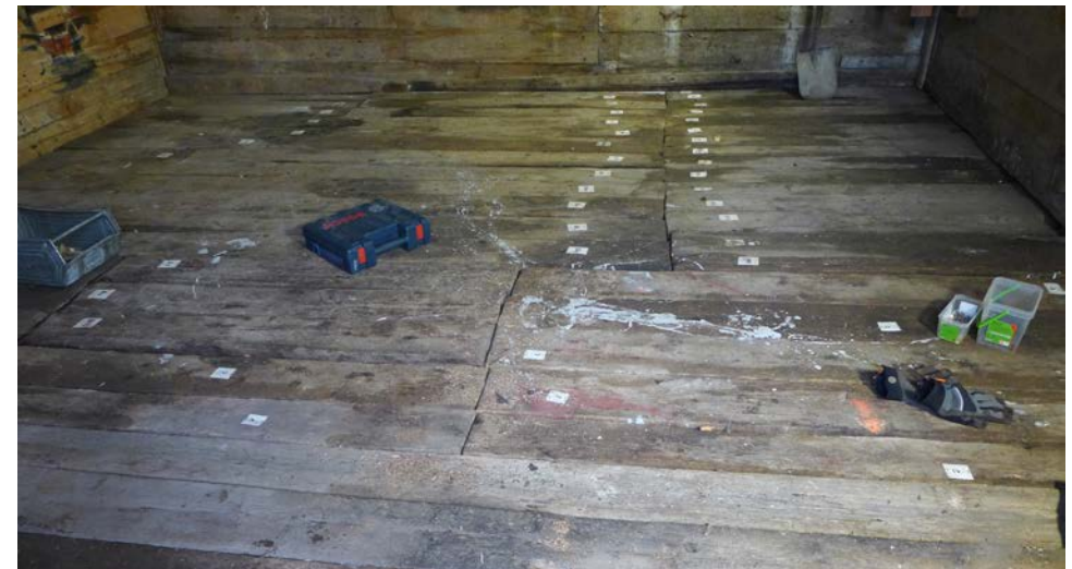
Det äldre golvet återmonterades efter byte av syll och golvbjälkar. 2017-11-15
