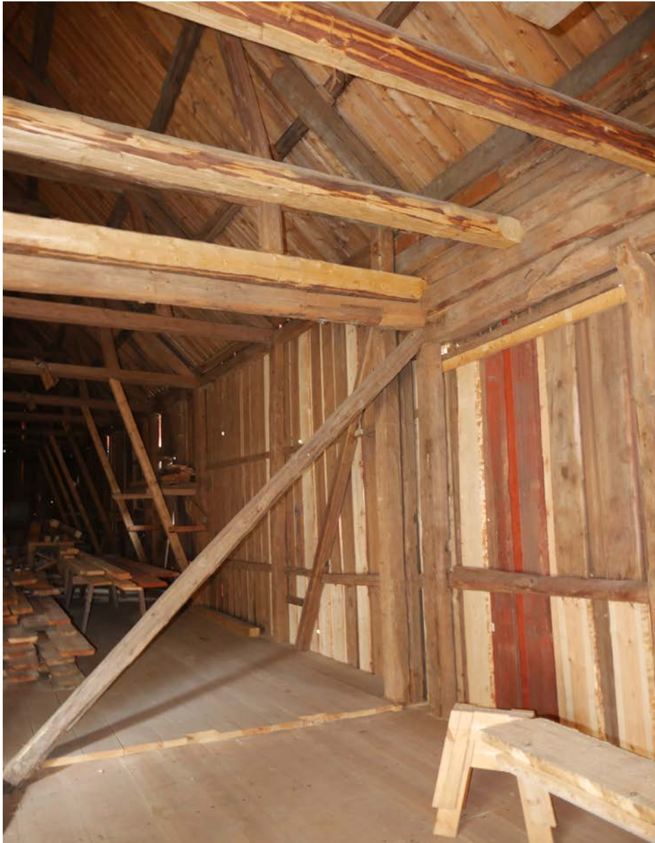
Efter avslutade arbeten Nya delen, fasad mot gården där man bl a ser nya bindbjälkar samt nordöstra hörnet med nya snedsträvor. 2018-08-22
