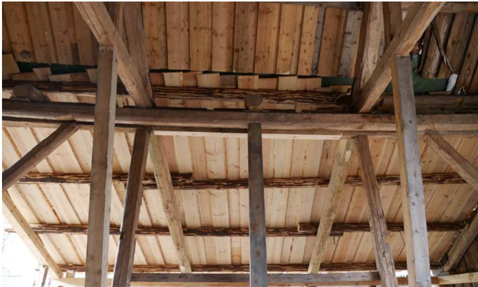
Pågående arbete med nytt tak till snedtäckan. Ny takinbrädning har monterats på åsarna. 2017-03-30
