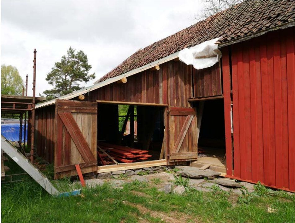
Äldre panel har återmonterats på snedtäckan efter montering av ny stomme. Panelen kommer dels från snedtäckan men också från övriga ladugården, där äldre rötskadade brädor kunnat kapas för att återanvändas som kortare längder till snedtäckan. 2017-05-22
