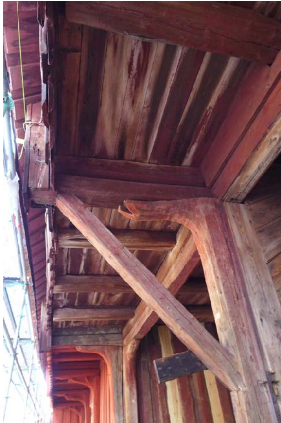
Återmontering äldre rotknän och snedstag, 2017-10-12. Bild längst t.h. visar den äldre delen med bevarade rotknän efter avslutade arbeten, 2018-08-22.
