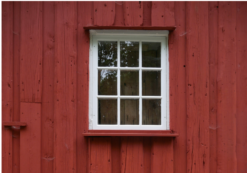
Byggnadens två fönster vetter mot öster har renoverats. 2018-08-22
