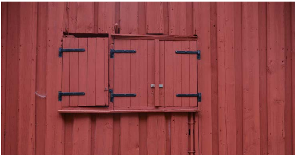
Urval portar efter avslutade arbeten. Ovan nytillverkade portar till rum 103, tjärade parportar rum 101 och nedan rödfärgsmålade luckor mot öster. 2018-08-22
