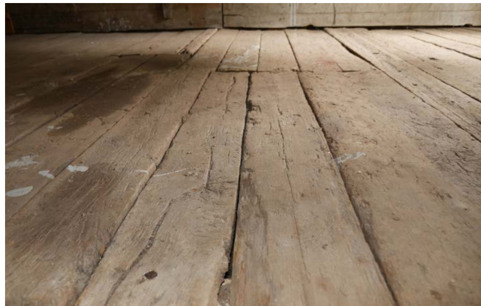
Det äldre golvet i rum 102 demonterades för lagningar av bjälklaget men återmonterades med bevarad patina. 2018-08-22
