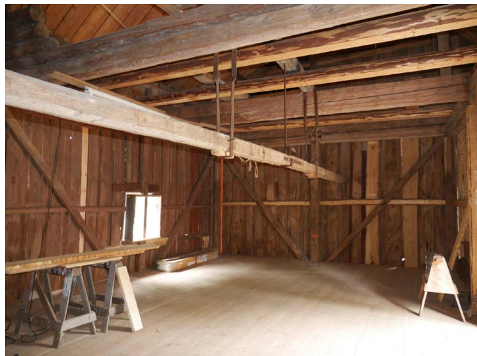
Stomlagningar och bl a ett par nya bindbjälkar i rum 103. 2018-08-22
