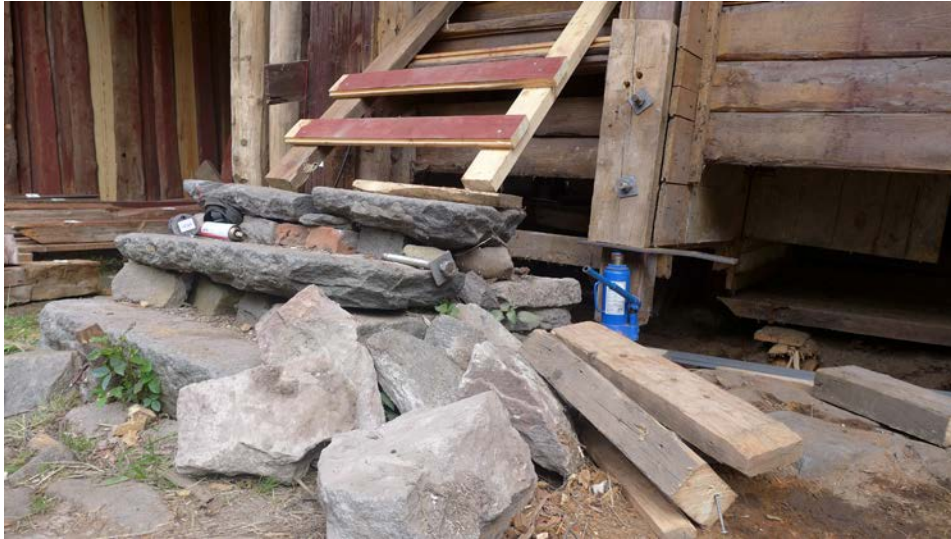
Stomlagningar vid trappa mot rum 102. Byte av syll m.m. 2017-06-28
