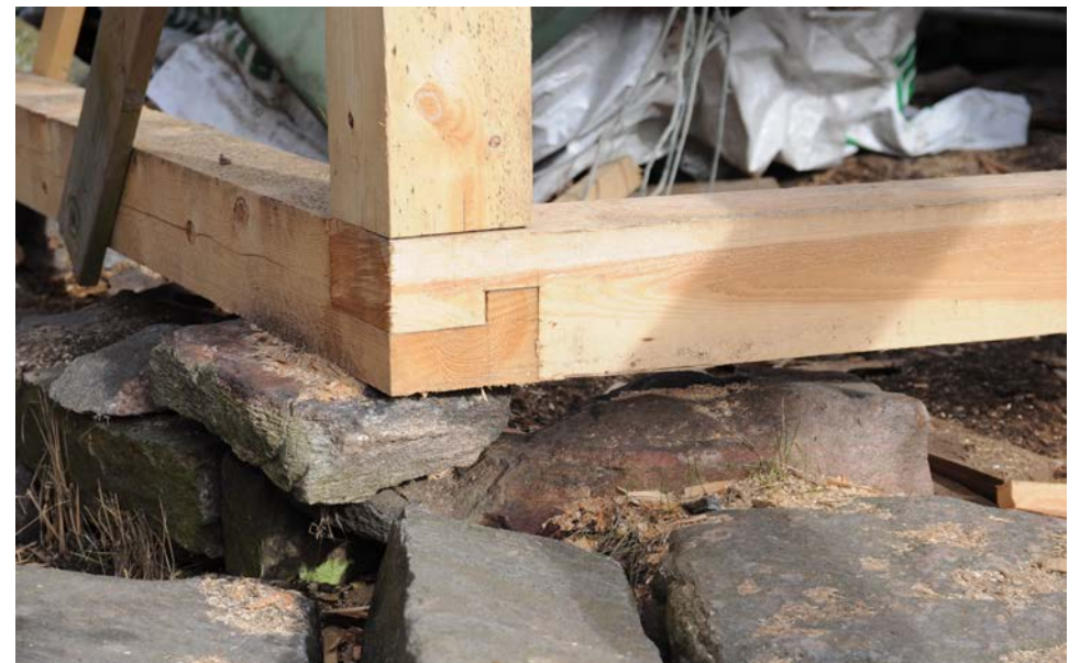
Pågående arbete med demontering av stommen. Hela stommen demonterades och stora delar ersattes med nytt virke i dimension lika befintligt pga omfattande skador. 2017-02-08
