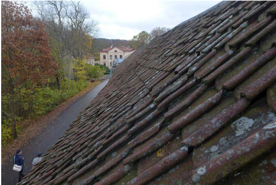
Före omläggning av tak. 2017-10-26
