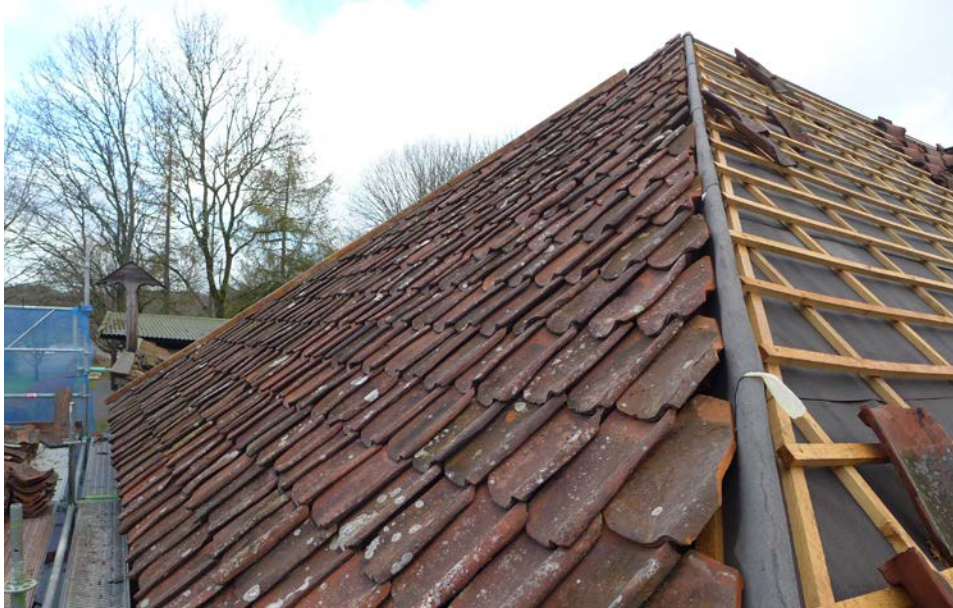
Under arbete med omläggning av tak mot öster och söder. 2017-09-15
