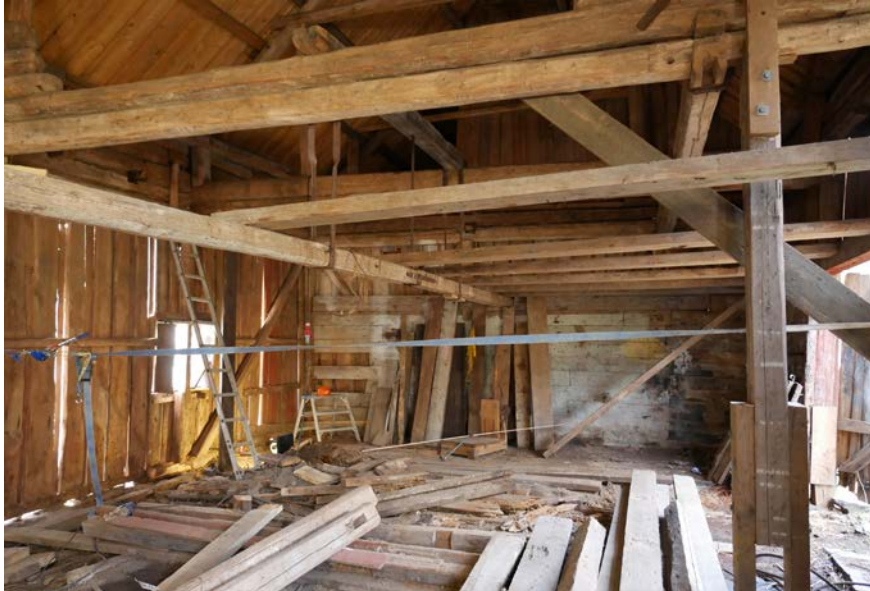
Interiörbilder Nya delen under pågående arbete med förstärkningar och lagningar av bl a bindbjälkar och takstolar. 2017-02-23.
