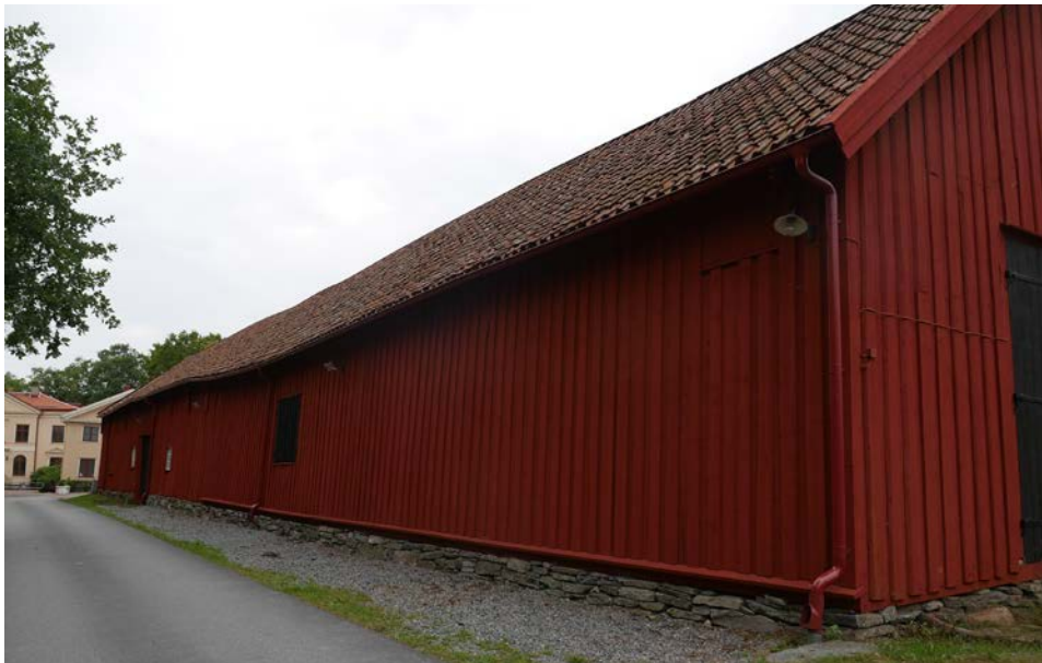
Efter avslutade arbeten med t ex lagning av panel om målning med Falu rödfärg. 2018-08-22
