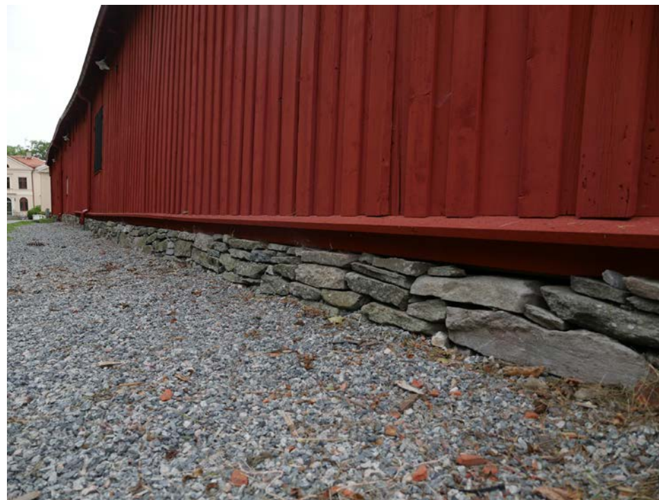
Grundläggning utmed östra fasaden efter avslutade arbeten. 2018-08-22
