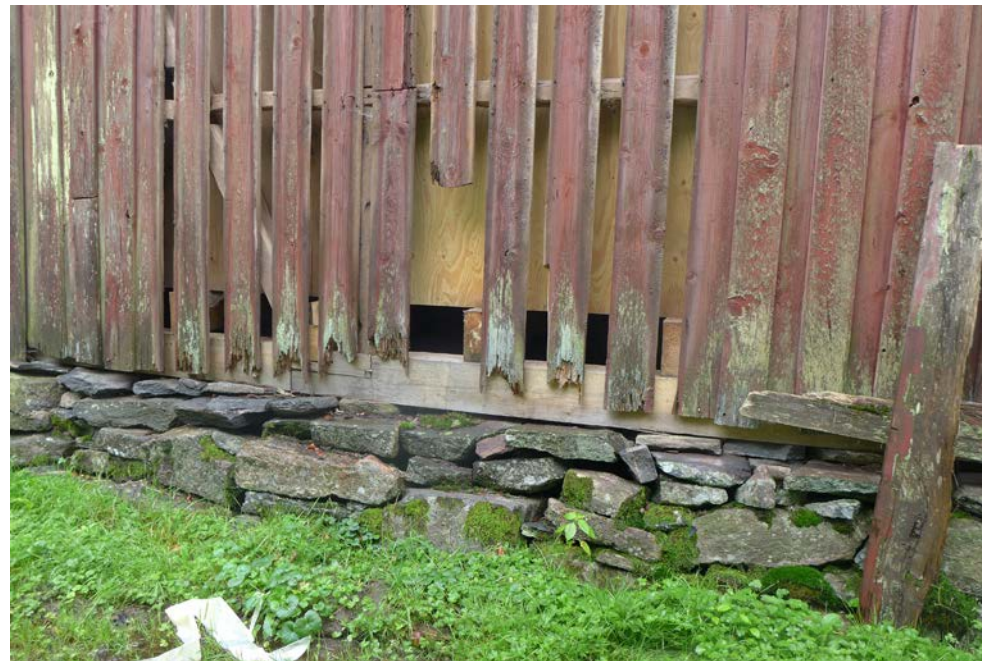
Fasad mot öster före restaurering med rötskadad panel i olika omfattning. 2017-09-13
