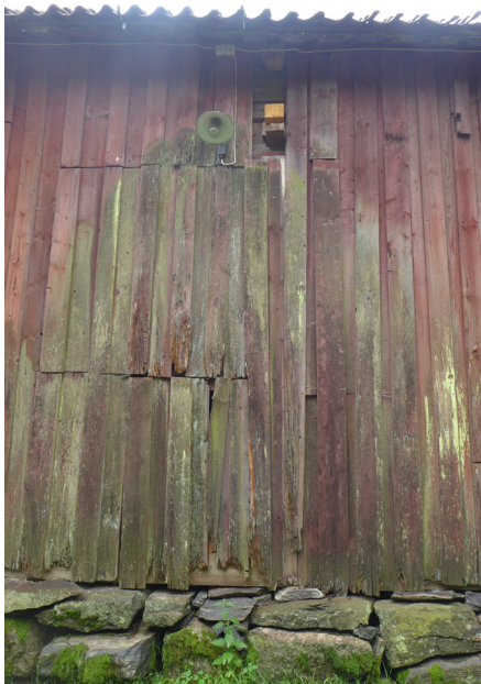
Fasad mot öster före restaurering med rötskadad panel i olika omfattning. 2017-09-13
