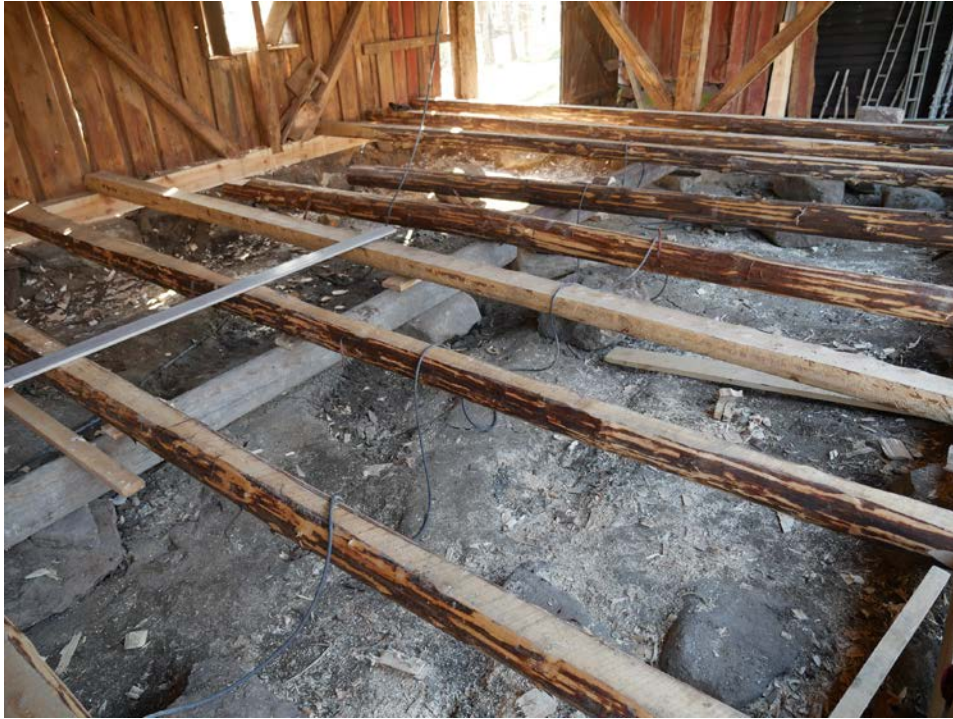
Komplettering med nya golvbjälkar i Nya delen. 2017-04-27
