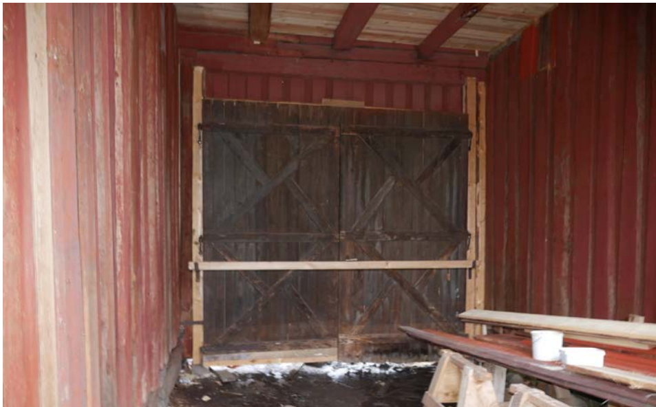
Nyttillverkning av portar till nytt indraget fasadliv mot rum 103. Nedan insida äldre portar mot portlidret före renovering. 2017-12-13
