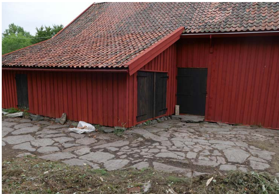
Pågående arbete med framtagning av markbeläggning på gården. 2018-08-22
