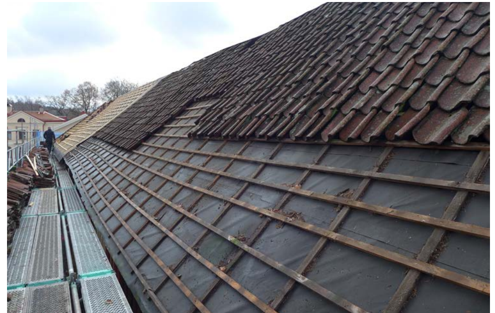
Under arbete med omläggning av tak, ovan mot väster och nedan mot öster. 2017-09-12 och 2017-11-15
