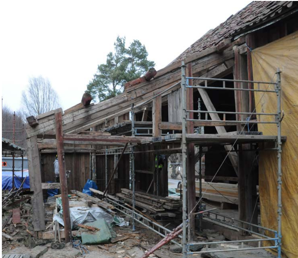
Pågående arbete med demontering av stommen. Hela stommen demonterades och stora delar ersattes med nytt virke i dimension lika befintligt pga omfattande skador. 2017-02-08
