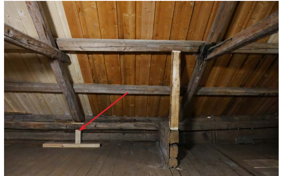
För att säkra nedböjning av långa längder så har remstycket förstärkts med stödben. Den övre bilden visar knäck på timmer mot öster och den nedre bilden förstärkning mot väster. 2017-11-29
