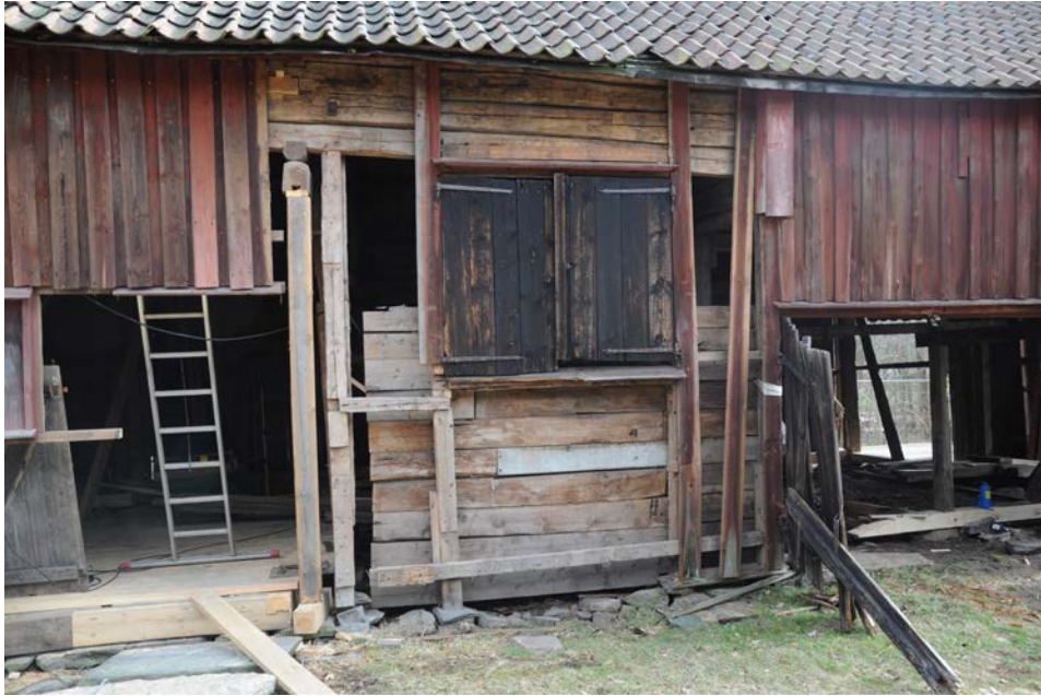
Pågående arbete med demontering av panel och delar av stomme för lagningar och kompletteringar. 2017-03-16
