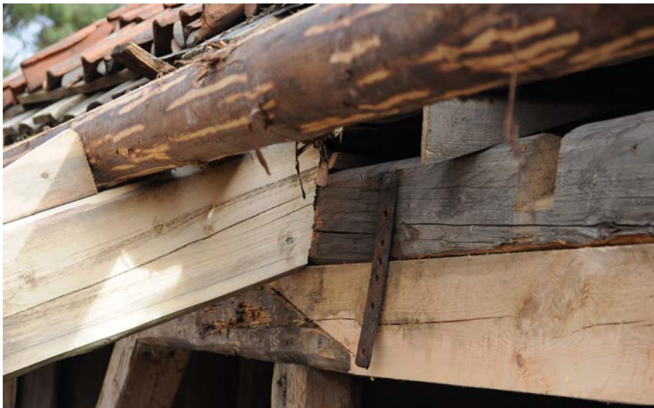
Pågående arbete med nytt åstak på snedtäckan och mötet mot Östra längan. 2017-03-16
