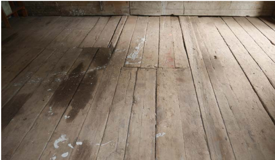
Rum 102 efter avslutade arbeten. Stomlagningar klara och det äldre golvet återlagd. 2018-08-22
