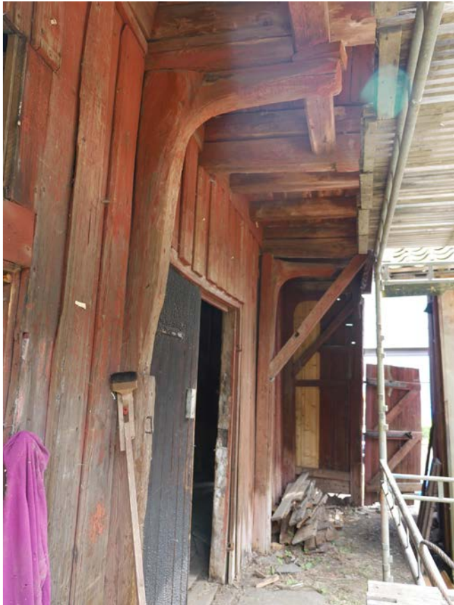
Återmontering äldre rotknän och snedstag, 2017-10-12. Bild längst t.h. visar den äldre delen med bevarade rotknän efter avslutade arbeten, 2018-08-22.
