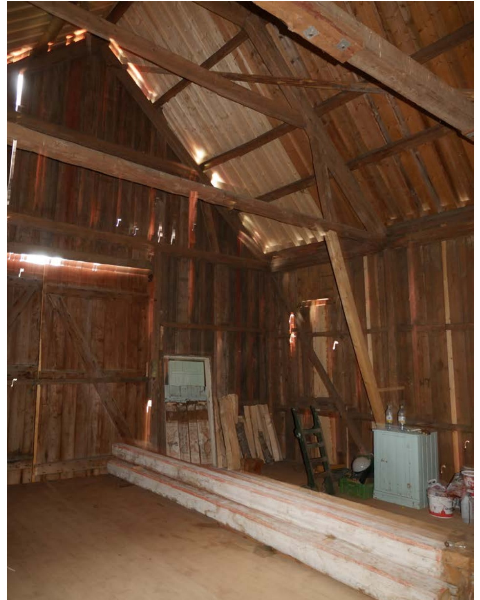
Efter avslutade arbeten Nya delen, fasad mot gården där man bl a ser nya bindbjälkar samt nordöstra hörnet med nya snedsträvor. 2018-08-22
