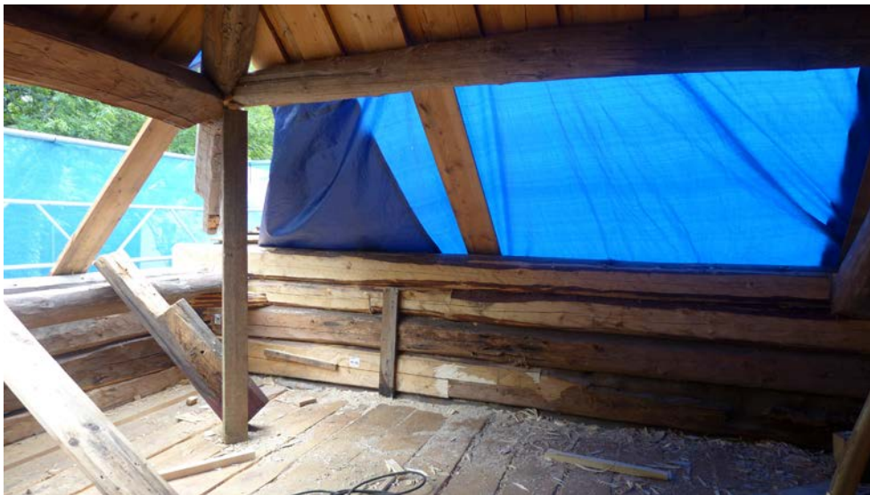
Överst t.v. visar tidigare lagningar och förstärkningar i sydvästra hörnet som medfört sättningar och förskjutningar av stommen. Övriga foton visar under arbete med bl a lagningar och utbyte av övre timmervarven mot syd. Det byttes även en del takinbrädning i sydvästra hörnet. 2017-05-22, 2017-08-16 och 2017-08-31
