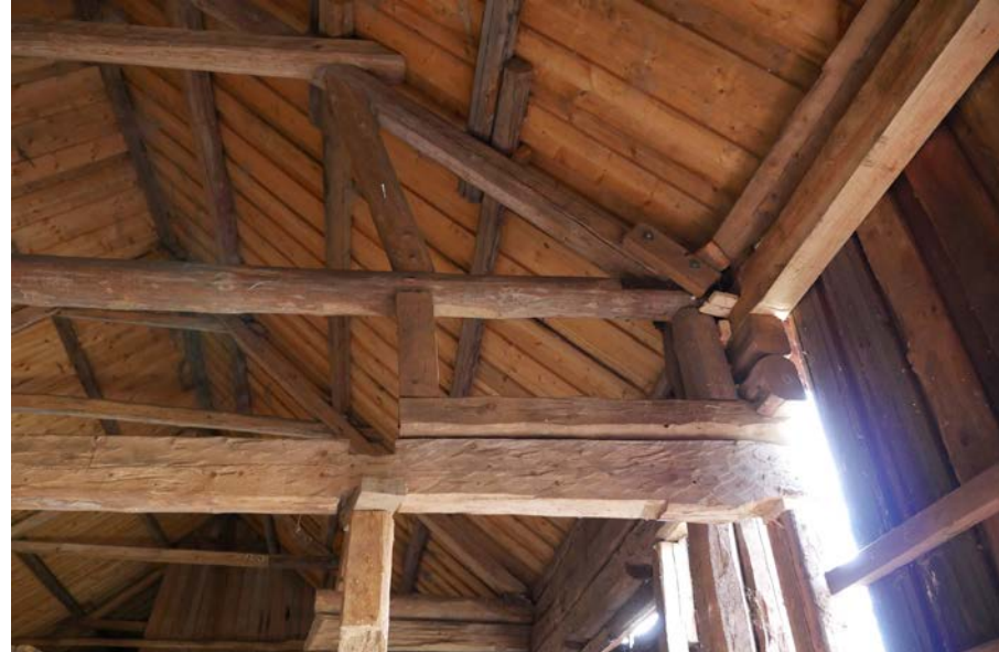
Interiörbilder Nya delen under pågående arbete med förstärkningar och lagningar av bl a bindbjälkar och takstolar. 2017-02-23.
