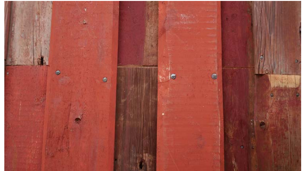
Återmonterad vägg i portlidret samt t.h. lagningar av panel mot öst och komplettering av ny vattbräda. 2018-11-15
