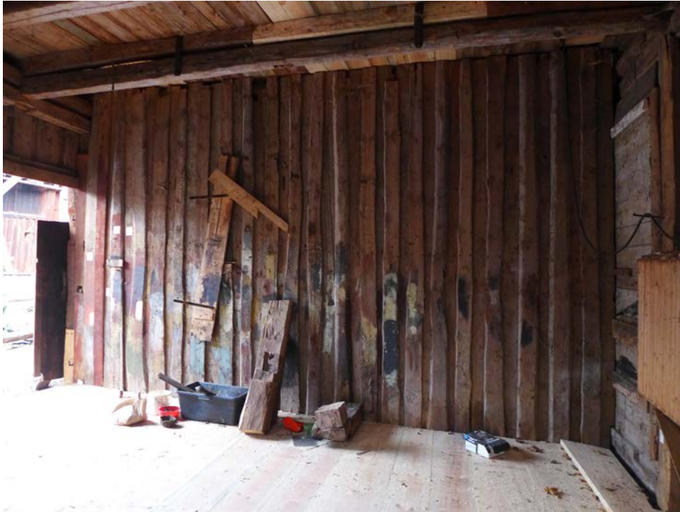
Återmonterad vägg i portlidret samt t.h. lagningar av panel mot öst och komplettering av ny vattbräda. 2018-11-15
