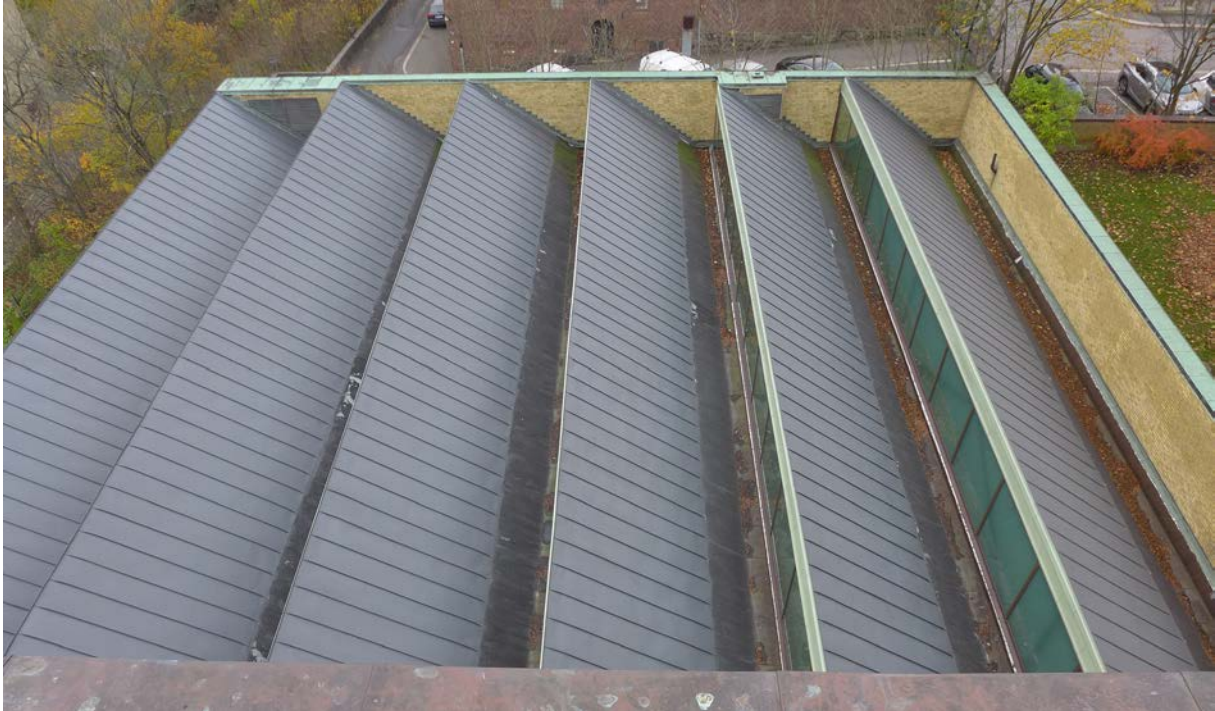
Etagens sågtandsformade tak med fönster för ljusinsläpp.
