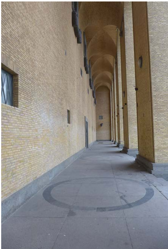
Arkadgången med kryssvalv i tegel och mönsterlagt golv.
