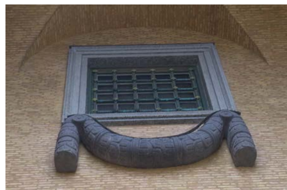
Festong i sten under ett ursprungligt fönsterparti av brons.
