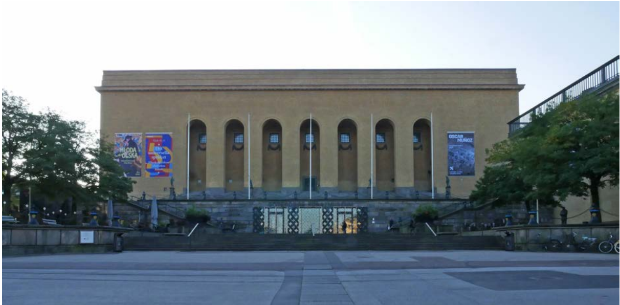
Huvudfasad mot Götaplatsen.
