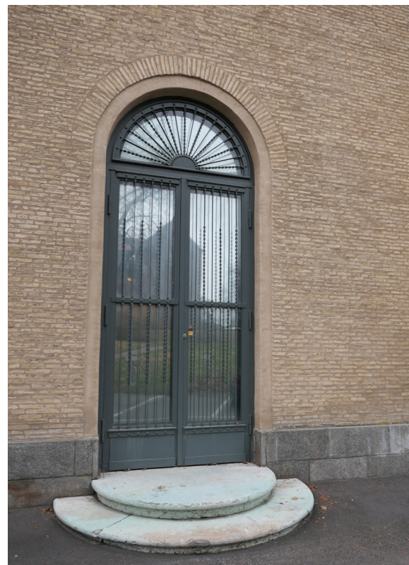
Ursprunglig pardörr av gjutjärn i sydfasaden.
