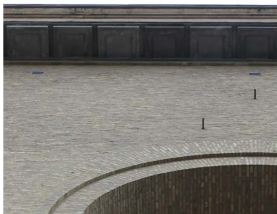
Detalj av takfot, fasad mot Götaplatsen.
