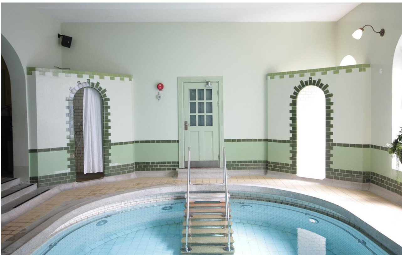
Philipsonska badet restaurerades 1996 och återställdes till originalutseende.
