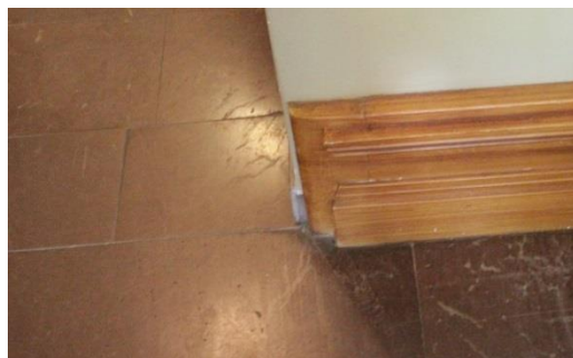
Rött kalkstengolv och ekådrad sockel.
