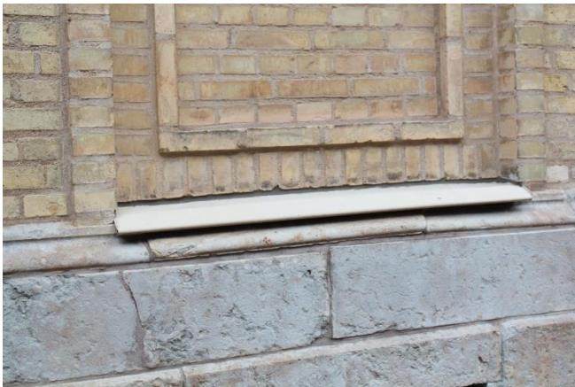
Plåt i underkant fönsterbröstning.
