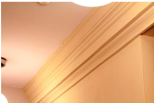
Profildragen puts på takfot i f.d. yttervägg.
