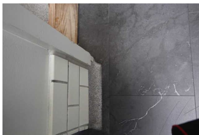
Gjutgolv med ett senare inlagt vinylgolv samt en sockel i kakel.
