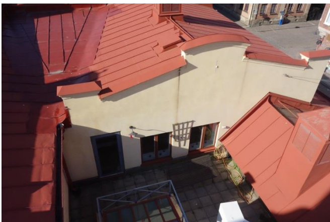
Takterrass och putsad fasadyta.
