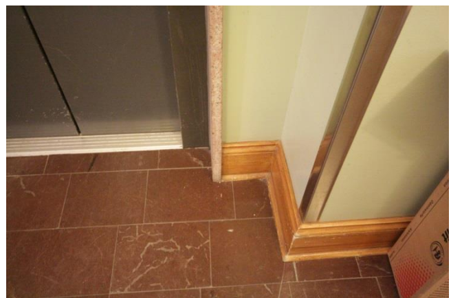
Rött kalkstengolv, ekådrad sockel.
