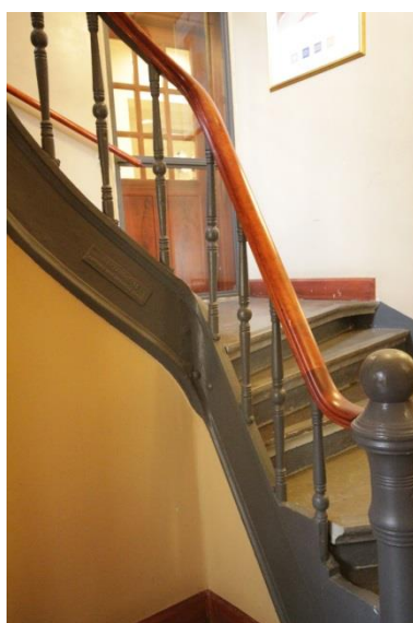
Trappa med stomme och spjälor i järn.
