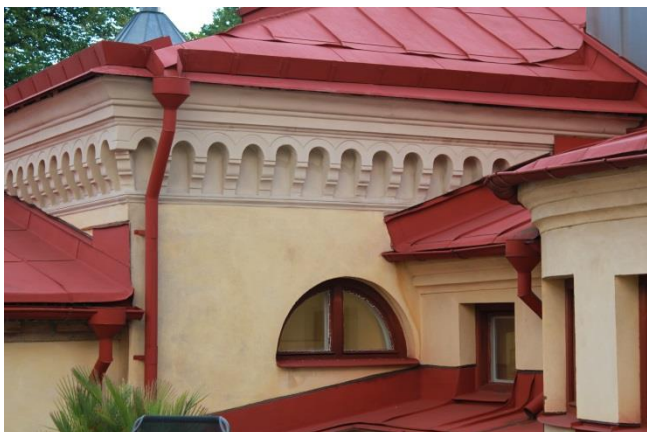
Putsad fasad mot takterrass.
