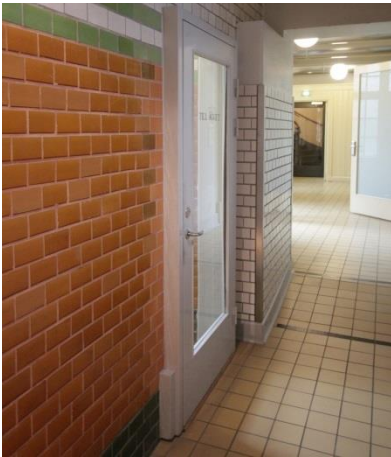
Dörr i trä och glas från 1996 till Ägget.
