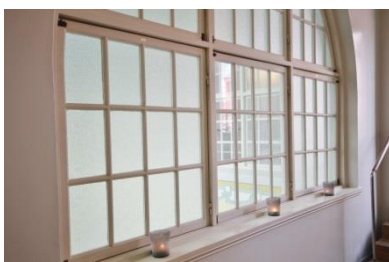
Välvt spröjsat fönster.
