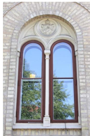
Okopplade spröjsade fönster av originaltyp mot norr.
