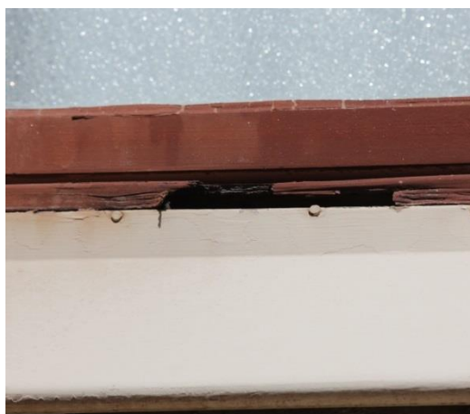
Röta i karmbottenstycke mot söder.
