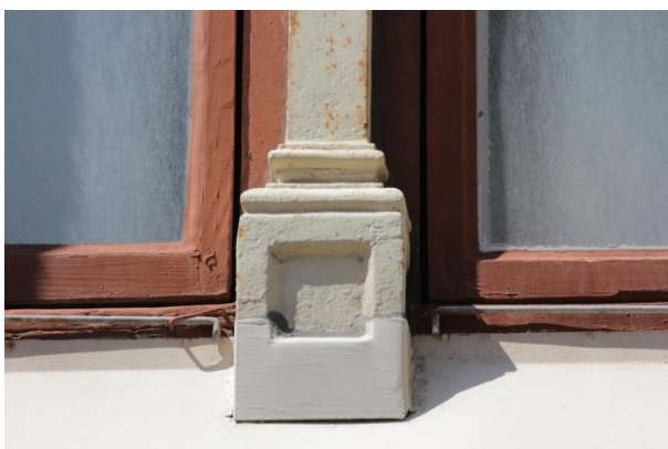
Kolonnnett i gjutjärn mellan välvda fönster.
