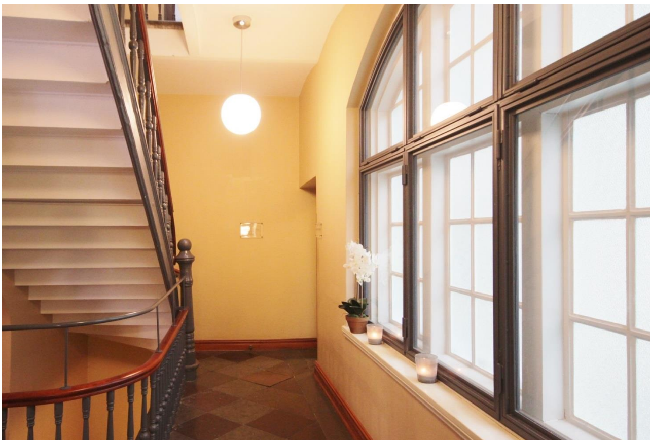
Trapphus med välvda spröjsade fönster mot simhallen. Fönstren är från 1906 men innanfönstren i metall är från 1996.
