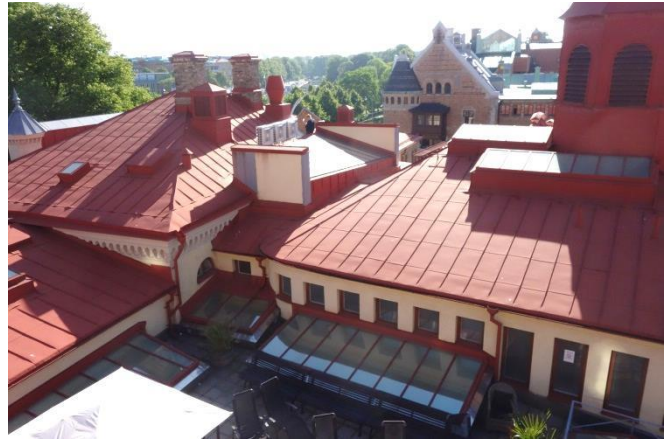
Skivtäckt takfall mot väster.
