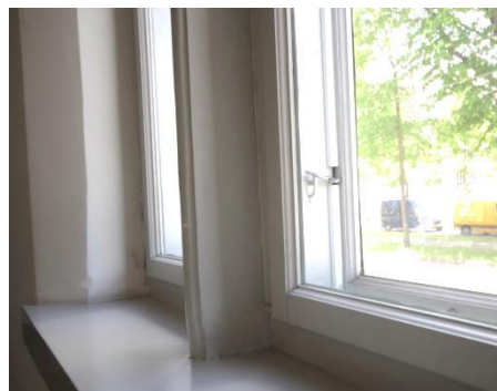
Okopplade fönster med profilerad mittpost.
