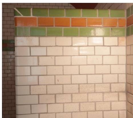
Duschvägg med originalkakel i rum B123.
