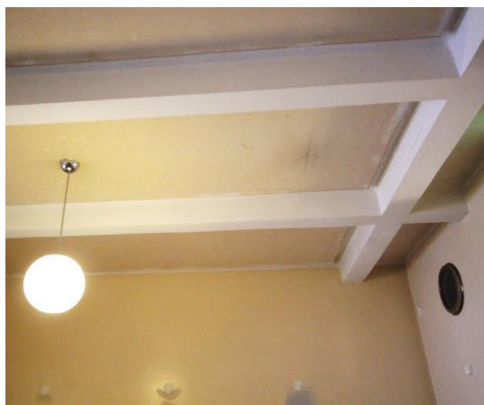
Tak med synliga balkar och limmade ljudabsorbenter.
