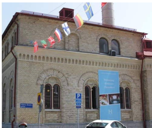
Denna del av fasaden mot öster är ommurad som skalmur med nytt tegel 1996.
