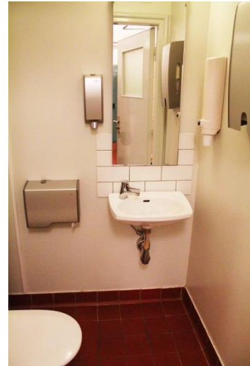
Toalett med golv och sockel i klinker.
