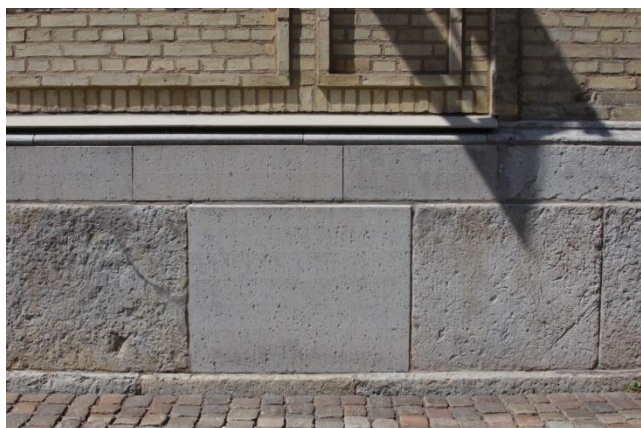
Sockel med vittrad originalsten respektive kompletterad slätare sten.
