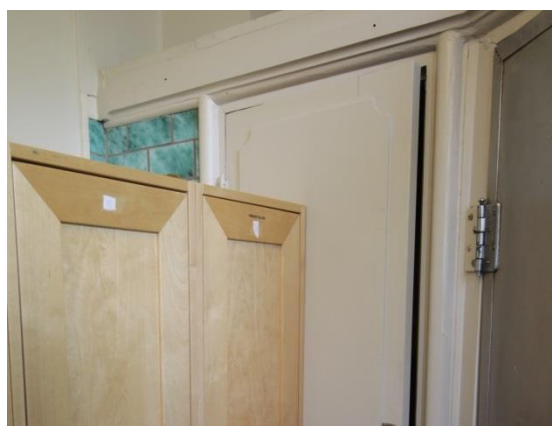
Inbyggt skåp bakom förvaringsskåp.
