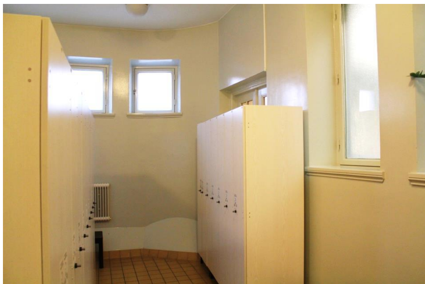
Omklädningsrum med klinkergolv och putsade målade väggar.
