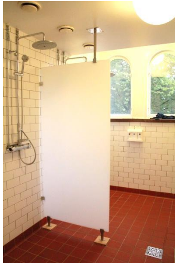
Duschrum, senare tillkommet, med klinkergolv och kakelvägg.
