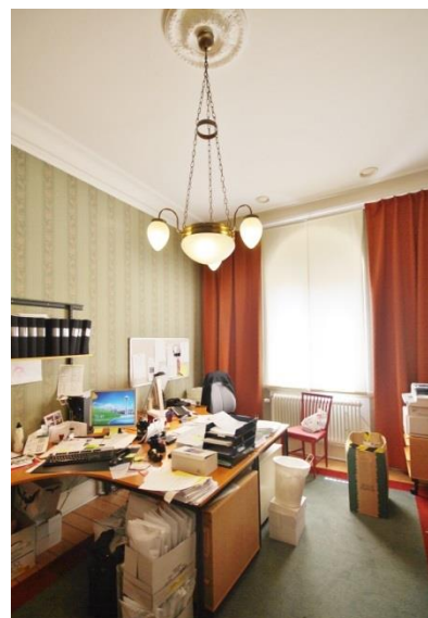
Enkel stucklist och takrosett.
