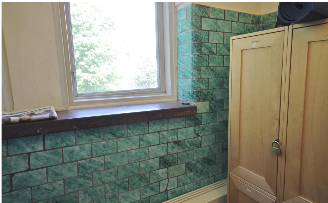
Rum med originalkakel från 1931. Rummet byggdes som badrum.
