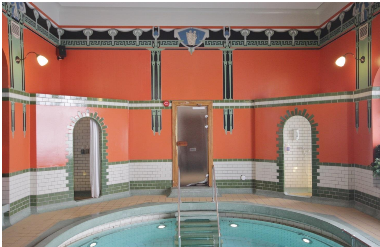
Romerska badet restaurerades 1996 och återställdes till originalutseende.
