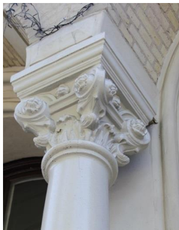
Kolonn med korintiskt kapitäl i gjutjärn målad med oljebaserad färg.
