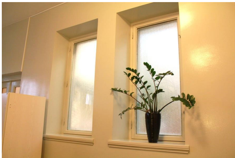
Enluftsfönster med råglas.
