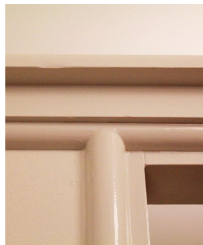
Väggen är utformad i stil med befintliga dörrar och foder från 1931.
