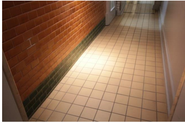
Originalkaklet är kompletterat med nytt klinker på golvet lika det i övriga rum.
