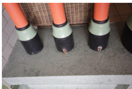
Pelare med rostande bultar i basen.
