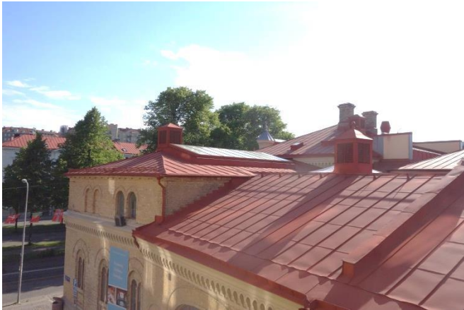
Skivtäckt takfall mot väster.
