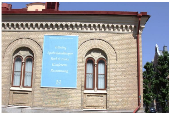
Fasad mot söder. Från hörnet fram till vepan är fasaden ommurad med nytt tegel 1996.
