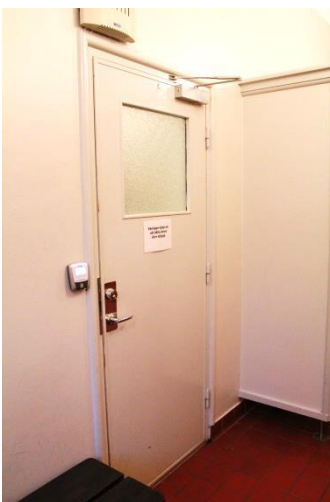
Dörr slät dörr med råglasfönster.
