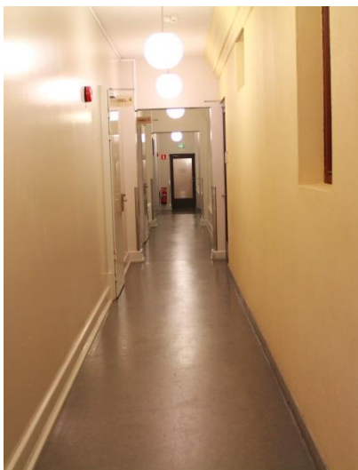
Korridor med putsad f.d. yttervägg till höger.
