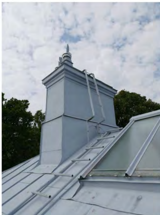
Taket är klätt med skivtäckt plåt i en zinkgrå kulör. I bilden ansas den yttre delen av lanterninen vilket på senare tid försetts med trådglas. Skorstenen i bild är endast en attrapp, murstocken har rivits.
