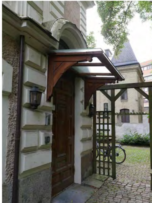
Huvudentrén på den norra fasaden med sitt ursprungliga dörrblad. Delar av skärmtaket är äldre, men kompletterat med glasskiva under senare tid.
