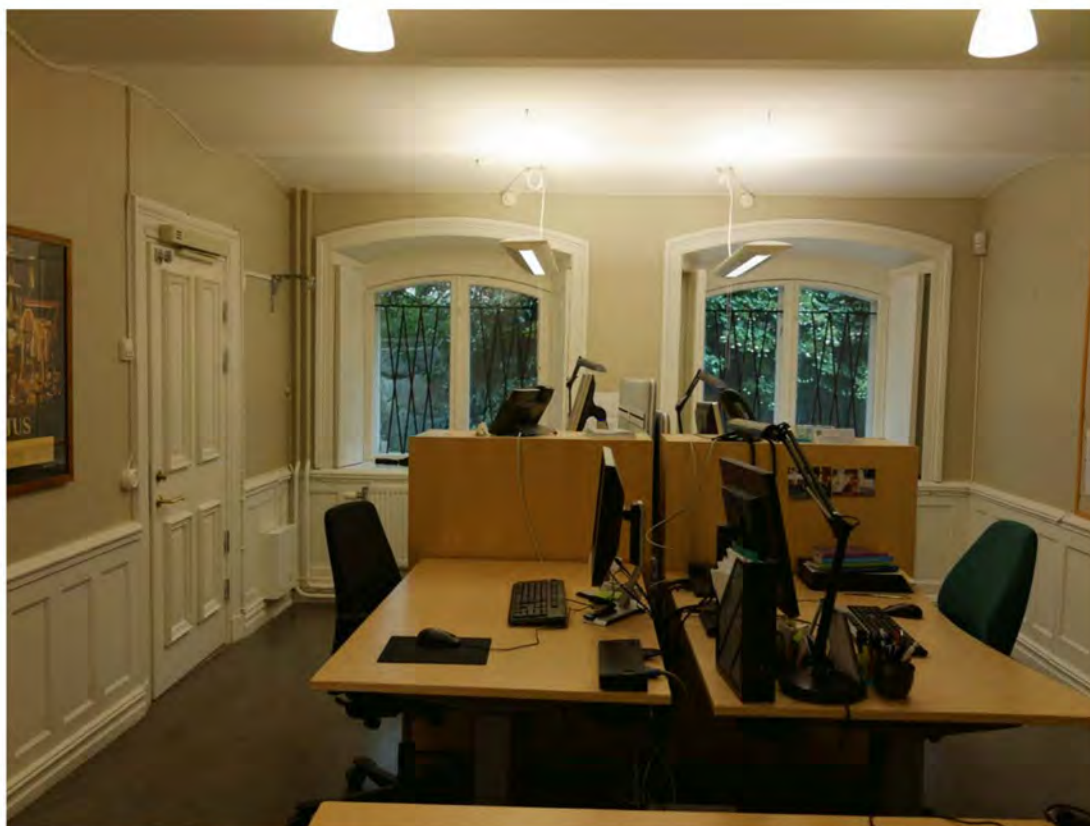
Plan 1, rum 103. Hela våningsplanet präglas av moderna material och ytskikt. Dock finns äldre fönster samt snickerier bevarade. På bilden syns två äldre fönster med ursprungliga fönsterluckor, liksom en ursprunglig bröstpanel.
