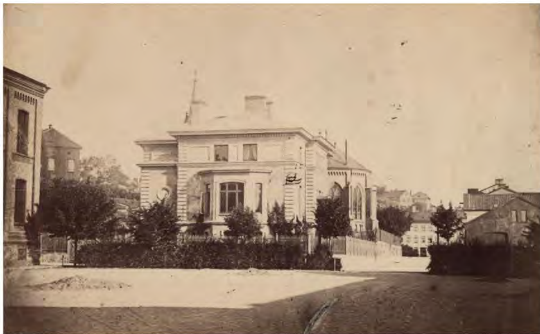
Foto från 1880-talet som visar Gegerfelt ska villans fasad mot läroverksgatan. Här syns burspråkets utförande före det byggdes på med en balkong på 1980-talet. Notera även det ursprungliga trästaketet som under 1940-talet ersattes med ett smidesstaket. Fotot visar också att det ursprungligen fanns mer växtlighet i trädgården. Källa: GSM
