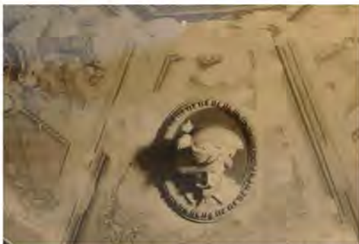
Detaljer av dekormåleri i vestibulen före konserveringen på 1960-talet. Konserveringen innebar att färgflagor fästes, skador kittades, övermålningar togs bort och därefter retuscherades de. Arbetena avsåg bl a den breda kornischen i vestibulen. Källa: GSM, foto: Lindén.
