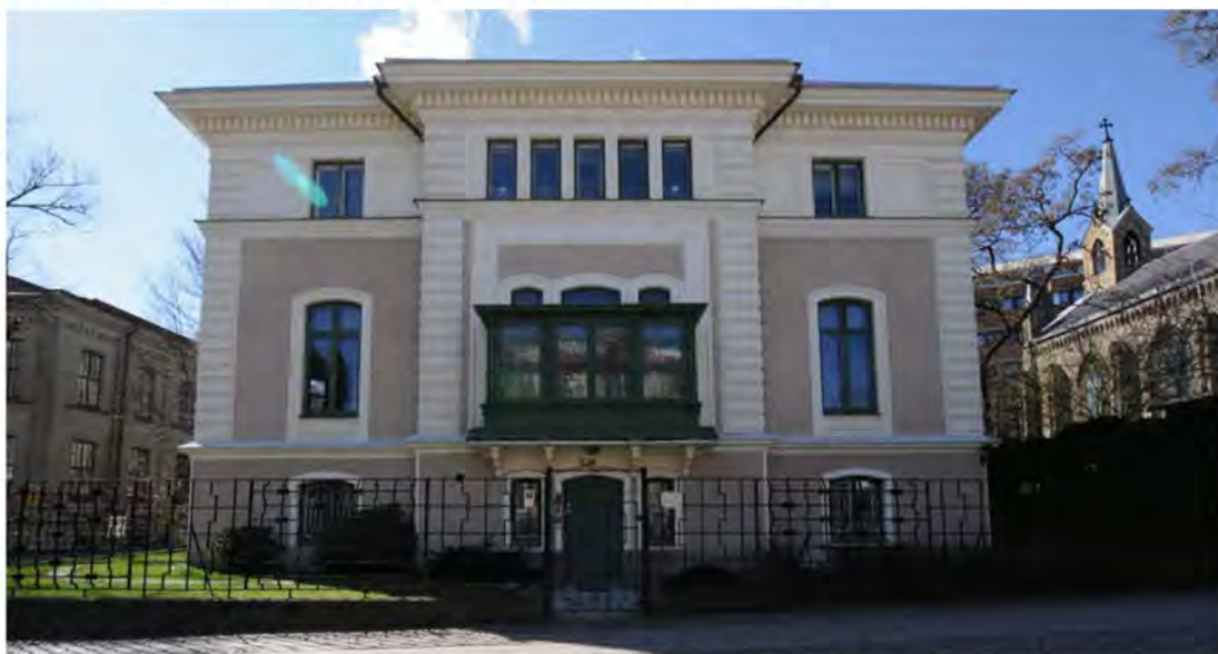
Fasad mot öst 2017 (mot arkitektgatan). Burspråket utgjordes troligtvis ursprungligen av en balkong som snart efter uppförandet byggdes om till burspråk. Entrén under burspråket togs upp 1934.
