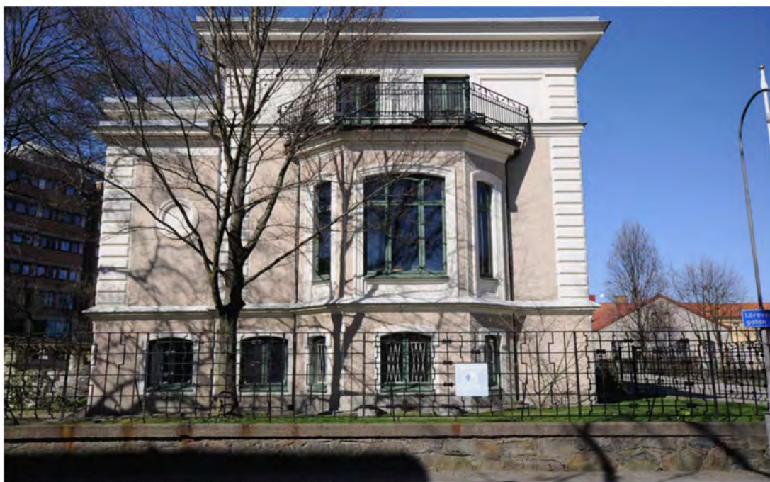
Fasader mot syd 2017. Burspråket byggdes på med en balkong på 1980-talet. Notera även den profilerade och slätputsade medaljongen som pryder fasaden.
