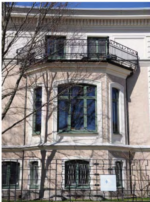
Putsat burspråk mot syd som byggts på med balkong på 1980-talet.
