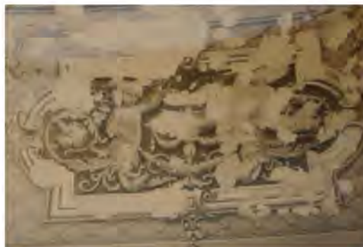
Detaljer av dekormåleri i vestibulen före konserveringen på 1960-talet. Konserveringen innebar att färgflagor fästes, skador kittades, övermålningar togs bort och därefter retuscherades de. Arbetena avsåg bl a den breda kornischen i vestibulen. Källa: GSM, foto: Lindén.
