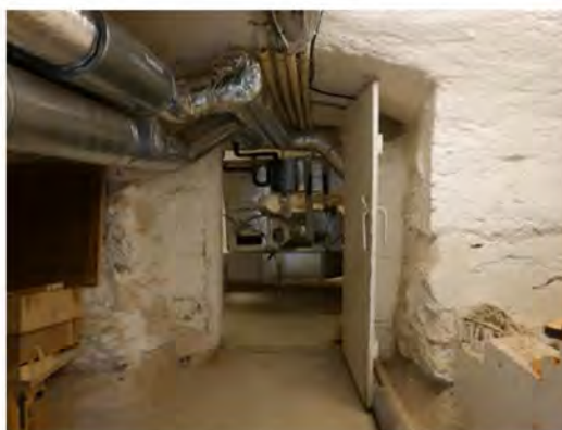
Foton från den välvda fd hushållskällaren, 2017. Golven är gjutna och målade. De murade väggarna och takvalven har en tunn offerputs och är målade. Under senare tid har det tillkommit mycket installationer i våningsplanet.
