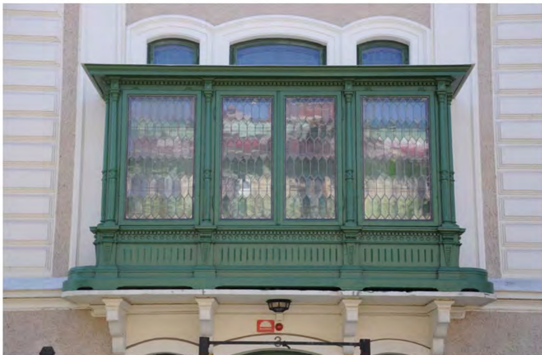
Det vackert utformade burspråket mot öst med sin trädekor och äldre blyspröjsade fönster. Notera den gjutna plattan samt konsolerna under burspråket, dessa kan tillhöra en ursprunglig balkong som ersattes med ett burspråk tidigt efter uppförandet.
